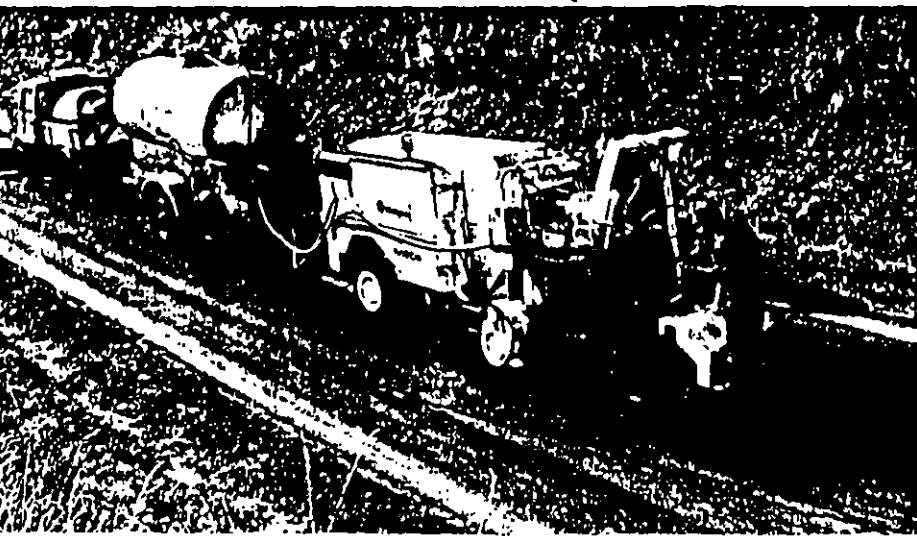
Iniciación de grietas reparando parcialmente una carretera antes de aplicar el tratamiento superficial.
