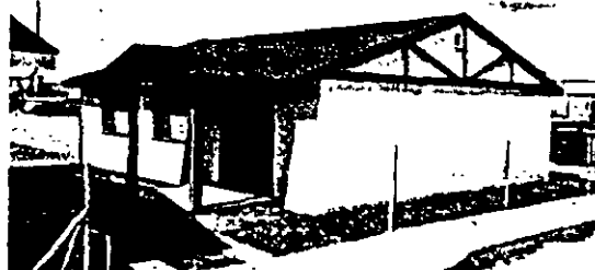
Techos y muros en casa de San Juan del Río, Querétaro.
