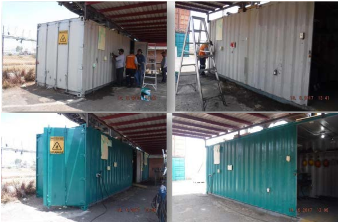
Fig. 33 Antes y después de la pintura exterior de un contenedor de almacén en la localidad de Aguascalientes.
