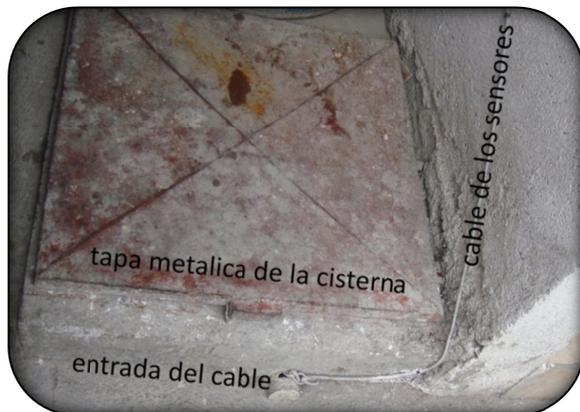
Ilustración 23: Tapa metálica de la cisterna de concreto.
