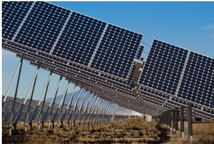
Figura IV.9. Generadores fotovoltaicos con sistema de seguimiento solar
