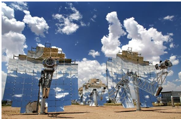
Figura II.12. Discos parabólicos con motor Stirling
