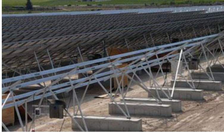
Figura II.16. Estructura de soporte de generadores solares
