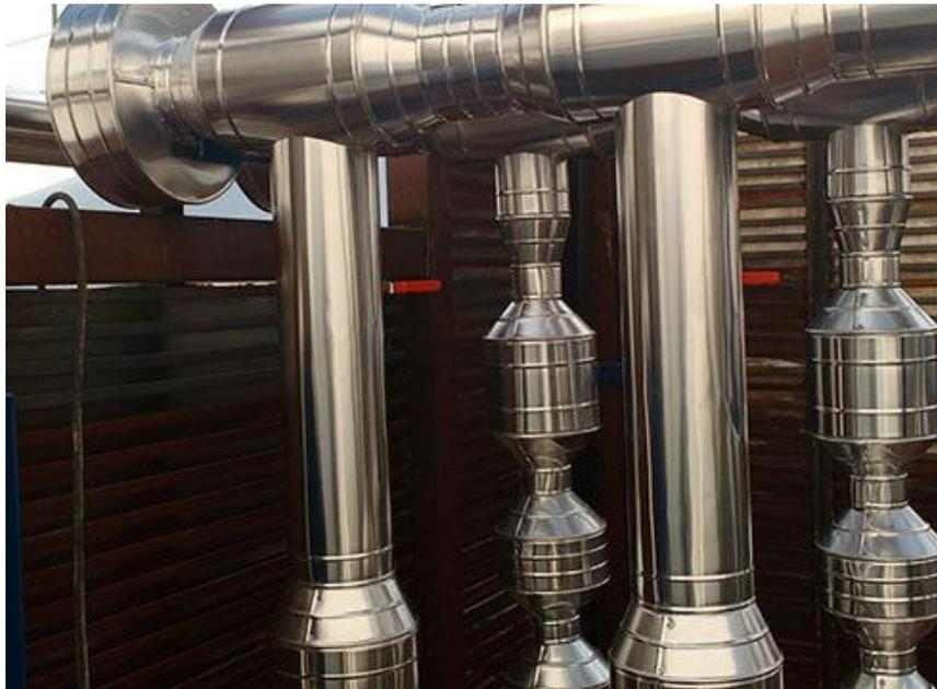
Protección mecánica de aluminio en tuberías exteriores
