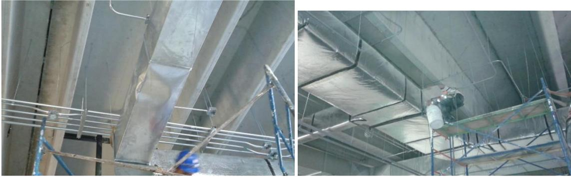
Ductos de lámina galvanizada de inyección de aire
