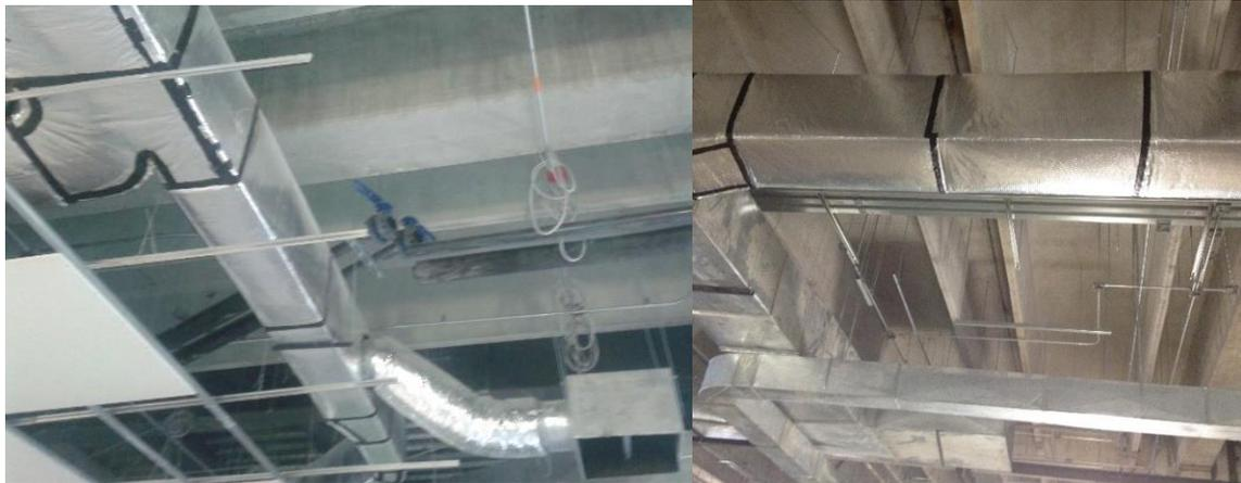
Ductos de inyección de aire acondicionado con aislamiento y ducto flexible
