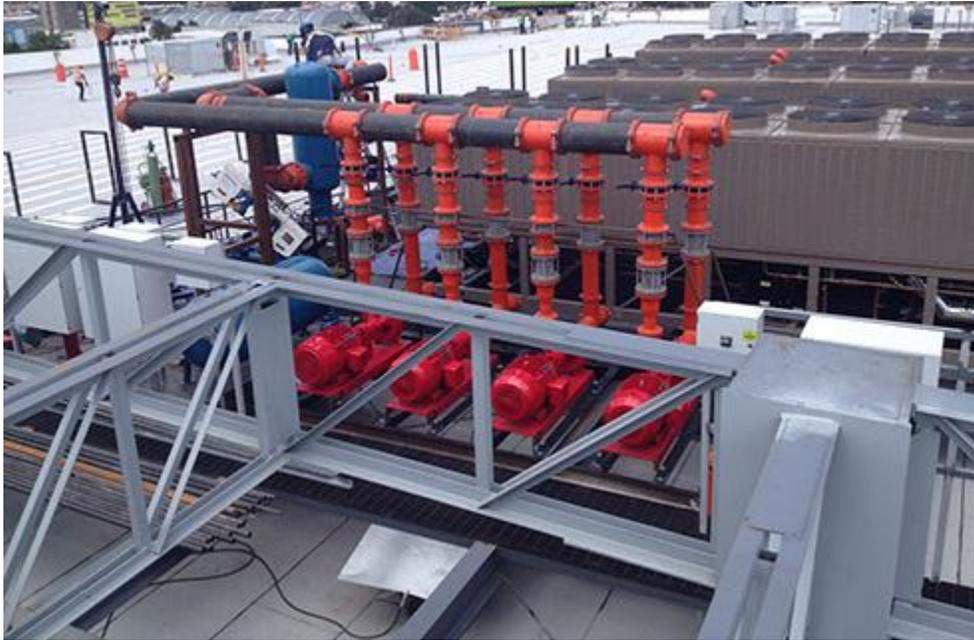
Cuarto de máquinas con bombas y chillers sin protección mecánica
