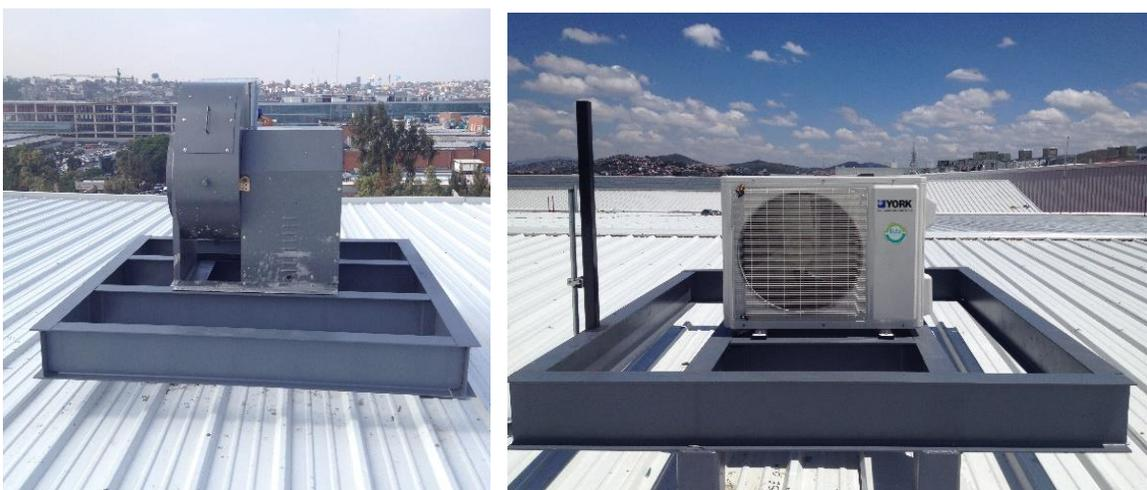
Ventilador de extracción y unidad condensadora para equipos divididos
