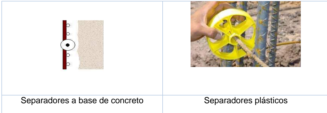
FIGURA 52. Imágenes de separadores de concreto y plásticos. “ICA Dirección de Puertos, agua y minería (2014), Documento 1205 TECII-CON-PTC-001, Rev. 03, p.p. (16).”
