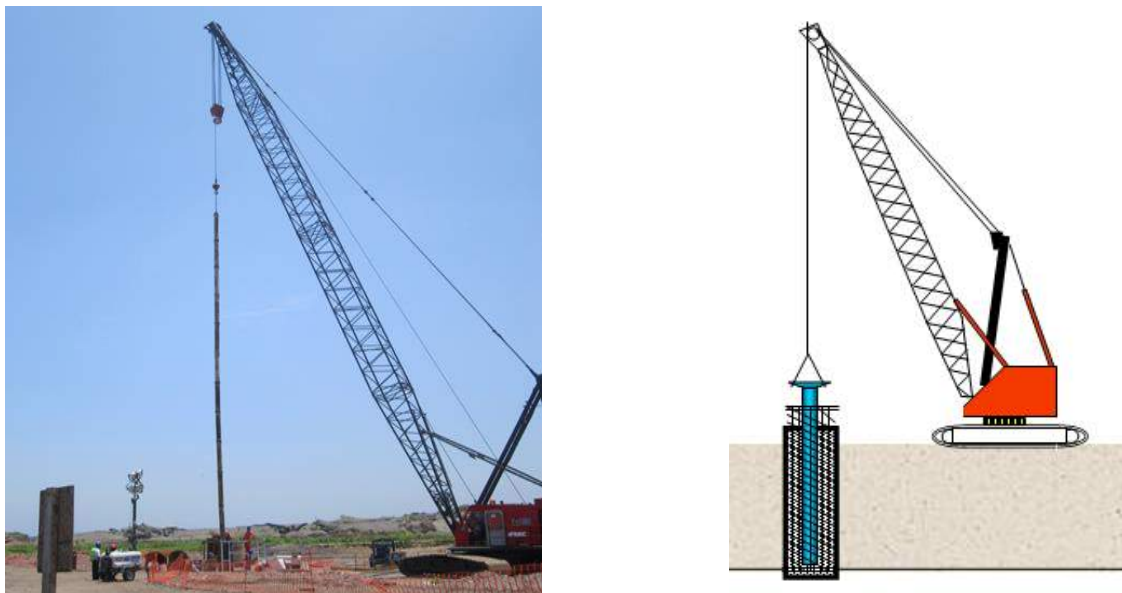
FIGURA 53-54. Colocacion de la tubería tremie. “ICA Dirección de Puertos, agua y minería (2014), Documento 1205 TECII-CON-PTC-001, Rev. 03, p.p. (17).”
