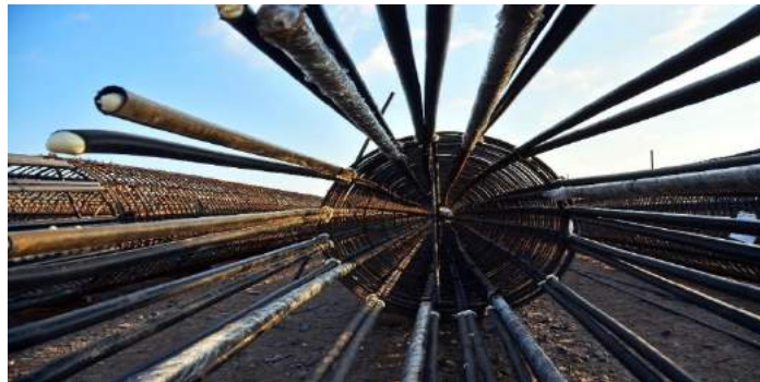
FIGURA 49. Armado de jaulas de acero. “ICA Dirección de Puertos, agua y minería (2014), Documento 1205 TECII-CON-PTC-001, Rev. 03, p.p. (14).”
