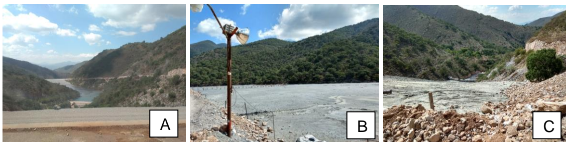
Figura 2.12. Presa de jales vista frontal (A), vista lateral (B) y profundidad (C).
