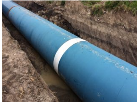
Figura 14. Colocación de cinta mecánica 955
