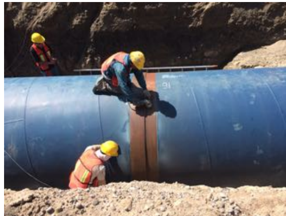
Figura 12. Limpieza SSPC SP-02
