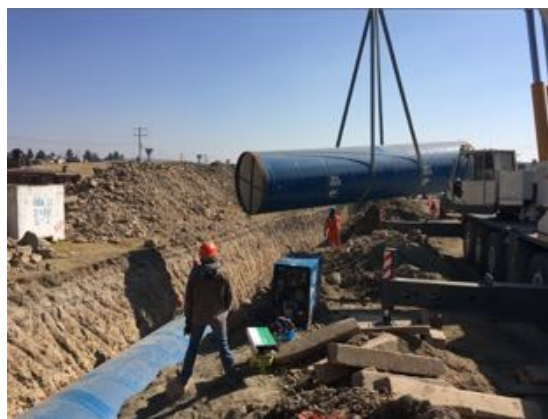
Figura 6. Bajado de tubería en zanja.
