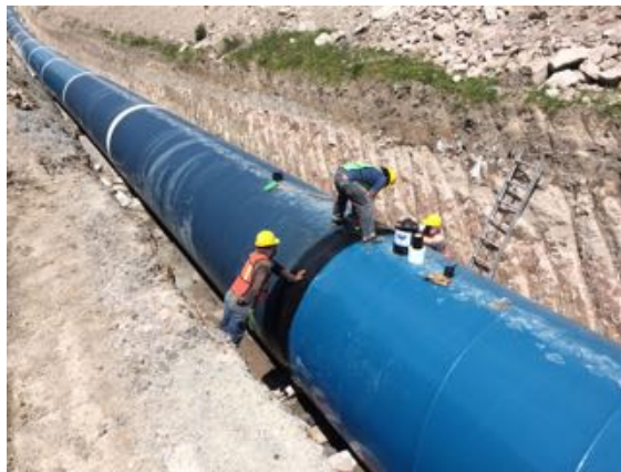
Figura 13. Colocación de cinta anticorrosiva 980
