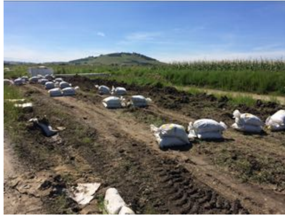
Figura 5. Soporte para descarga de tubería
