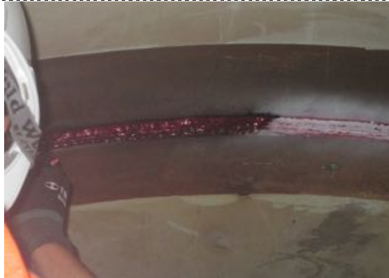
Figura 10. Aplicación de líquidos penetrantes
