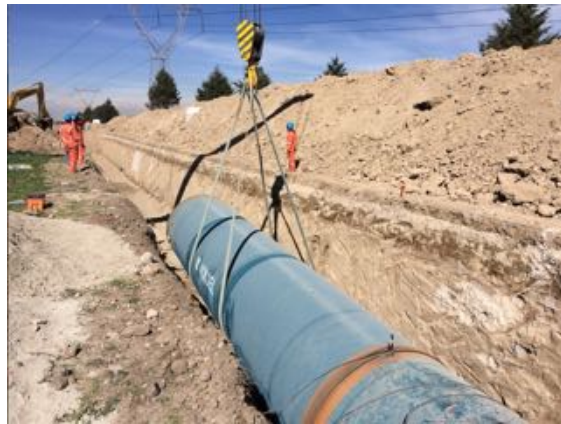
Figura 7. Ensamblaje de tubería.
