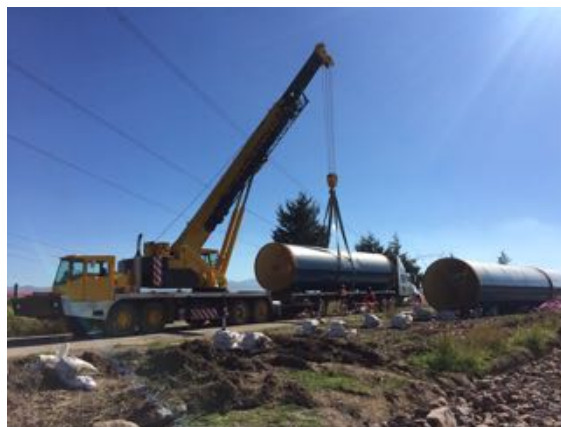
Figura 2. Descarga de tubería
