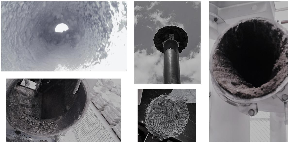
Figura. 55 – Incrustaciones en la tubería de la línea de tostado de café
