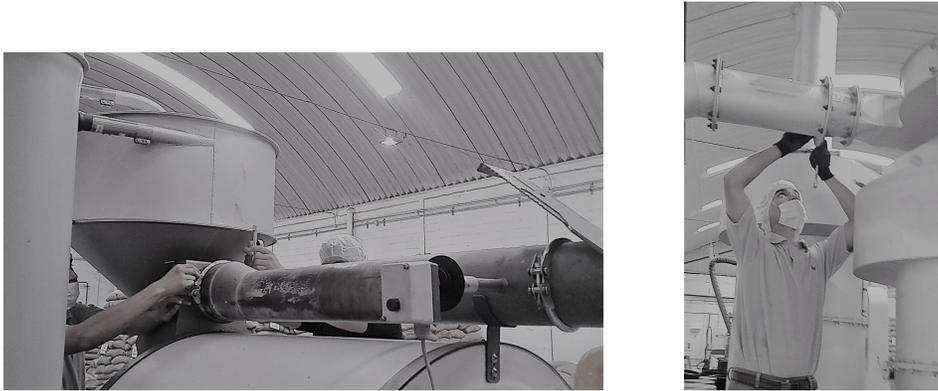
Figura. 54 – Desarmado de las tuberías por donde se realiza la succión
