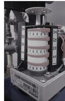
Figura. 51 – Quemador y regulador de leva mecánica
