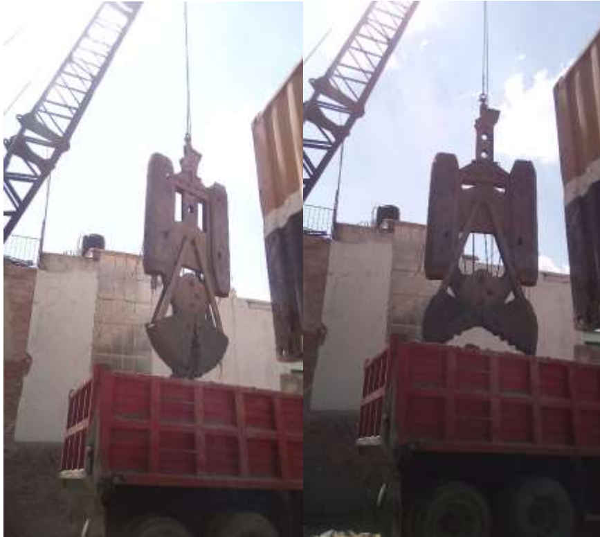
Fotografía 1.5 y 1.6 donde se observa la “mordida” de la almeja
