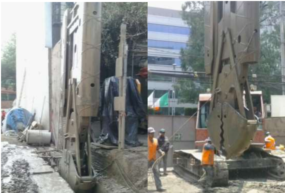
Almeja excavando fotografía 2.9 y 2.10
