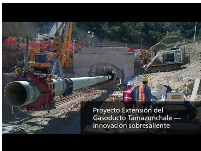
Figura 5.11 Construcción de Gasoducto Tamazunchale 27 , (Transcanada)
