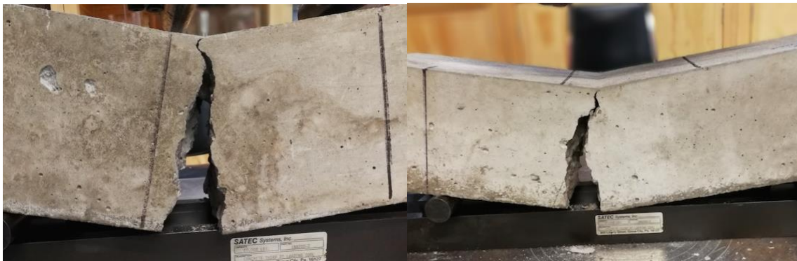
Falla en vigas testigo
