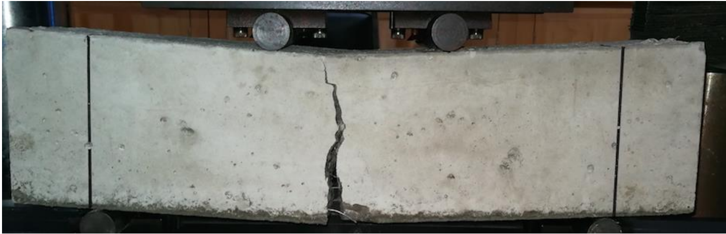
Falla en viga con 0.5% de fibra grande
