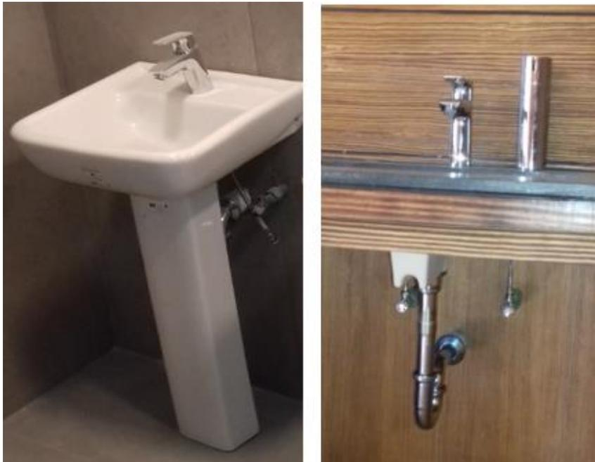
Figura 49. L. de pedestal - L. sobre cubierta.
