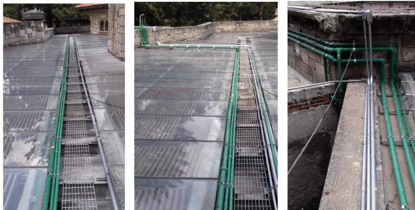
Figura 21. Tendido de tuberías hidráulicas, Azotea.
