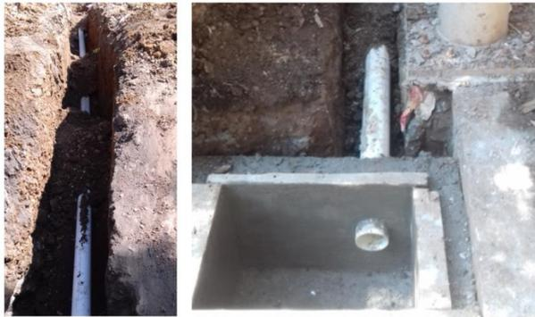
Figura 31. Izq. Tubería PVC sanitario en cepa, Der. Registro sanitario solicitado.
