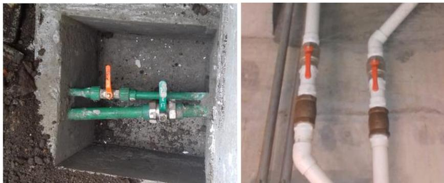
Figura 24. Izq. C.V. hidráulico, Der. C.V. sanitario
