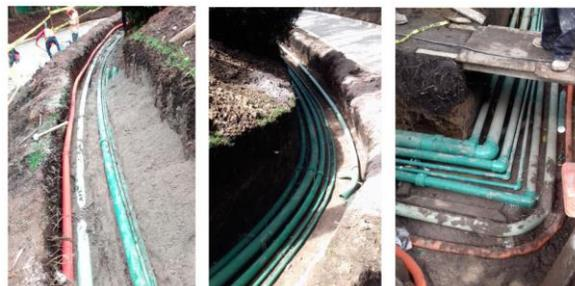
Figura 17. Izq. Encofrado, Ctral. Tendido de tuberías, Der. Hacia Cto. de máquinas 5.2.2.
