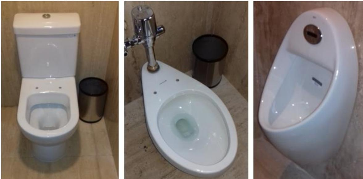
Figura 47. W.C. tanque - W.C. fluxómetro - Mingitorio con sensor.
