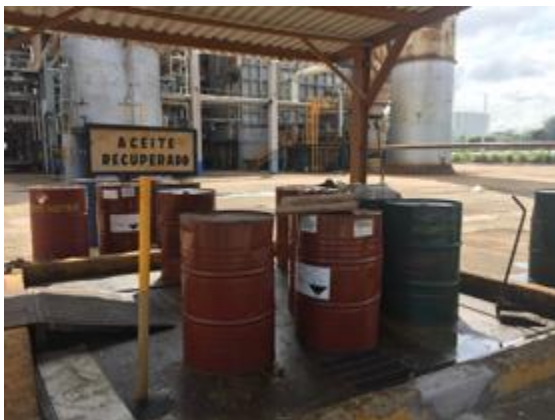
Figura II.6. Área de transferencia de residuos peligrosos de la planta de amoníaco 7. Fuente: Complejo Petroquímico Cosoleacaque.
