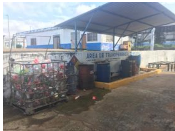
Figura II.7. Área de transferencia de residuos peligrosos de Mantenimiento Civil. Fuente: Complejo Petroquímico Cosoleacaque.
