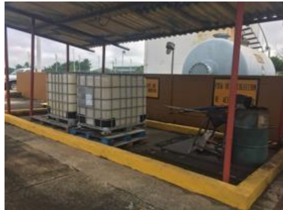
Figura II.5. Área de transferencia de residuos peligrosos del área de Movimiento de Productos. Fuente: Complejo Petroquímico Cosoleacaque.
