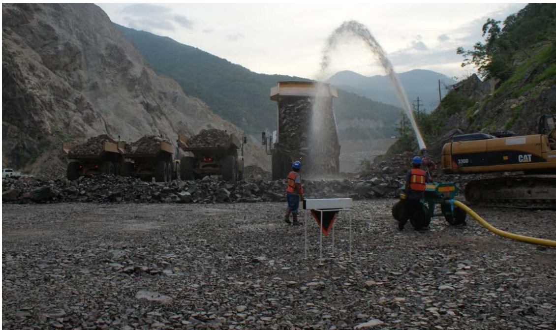
Ilustración 3-1 Humectación del enrocamiento durante su colocación en una presa (Cortesía CFE)
