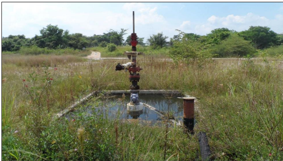
Figura 2.11 Instalaciones superficiales del pozo A.
