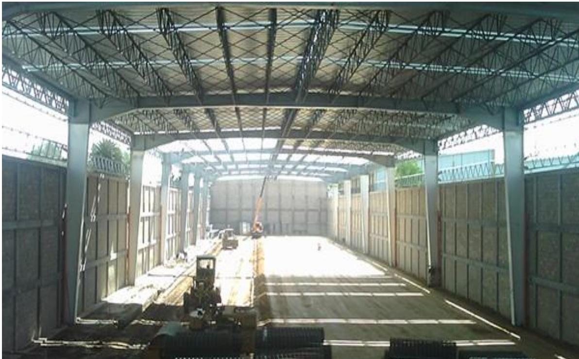
*Imagen 12: Ejemplo de una nave industrial construida con elementos variados, se pueden apreciar los muros de block, la estructura de acero y las armaduras.*
