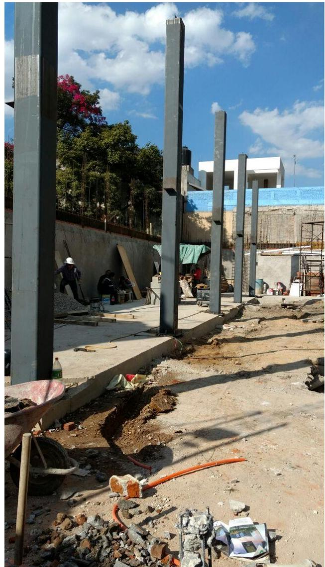
*Imagen 81 y 82 : Levantamiento de columnas de acero*
