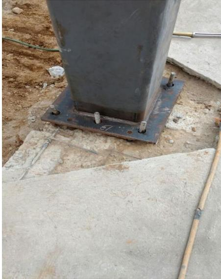
*Imagen 83: abotonamiento de columnas.*
