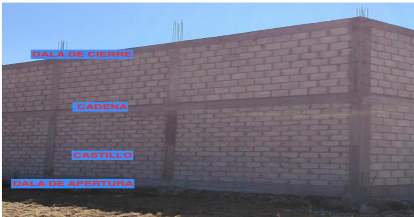
*Imagen 73: Componentes de los muros de block.*
