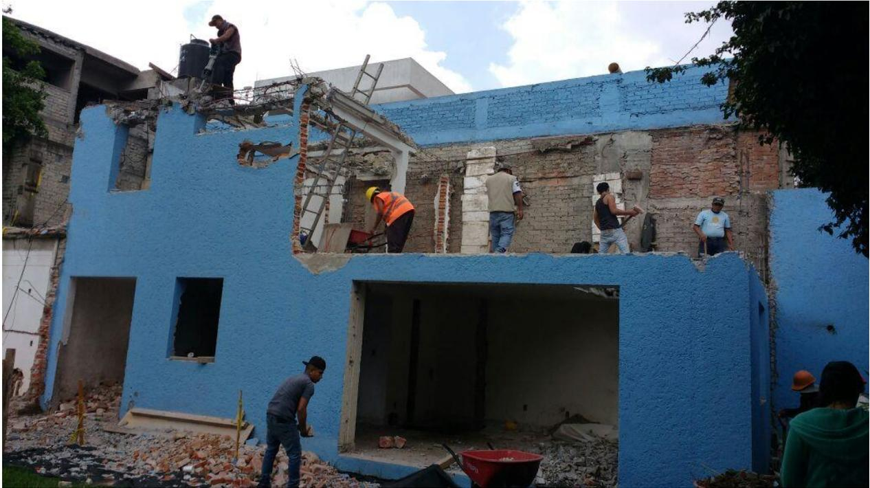
Imagen 48: Demolición de planta alta cuerpo B.
