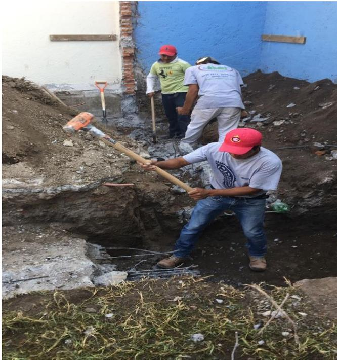
*Imagen 50: Demolición de cimentación.*
