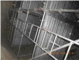
Se rearma andamio, con una distribución distinta a fin de alcanzar a todos los lugares que será necesario con el andamio que se cuenta, queda validado (Personal de seguridad planta) para iniciar trabajos de demolición en nivel 4.
