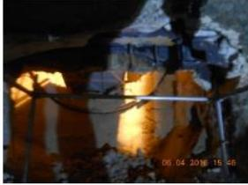
En el enfriador se continuó con limpieza y demolición de arco, importante rescatar que el escombros debía retirarse al nivel inferior, para lo que hicieron falta un par de ayudantes, retirando hasta 17.5 m<sup>3</sup>.
