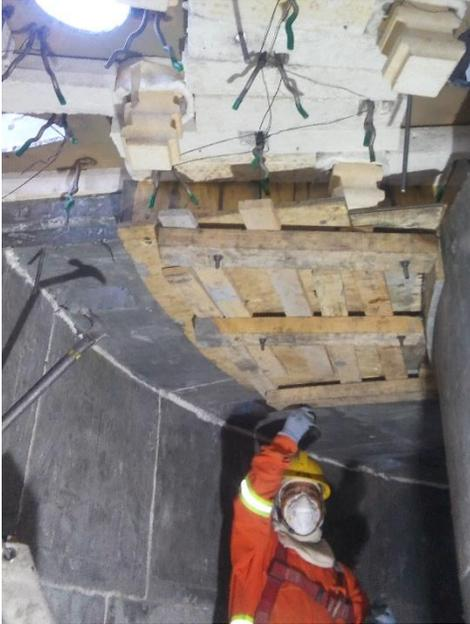
Fig. 4 Colado de concreto por secciones
