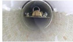
Instalación de placa aislante y cierre de 22 anillos en Ducto, así como tendido de 22 medias cañas, quedando a mitad del DAT, con ladrillo MAXIAL 334 SIC.
