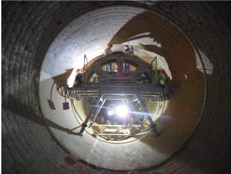
Fig. 6. Carro motorrin para cierre de anillos horno de cemento. (Fuente: Fotografía propia).
