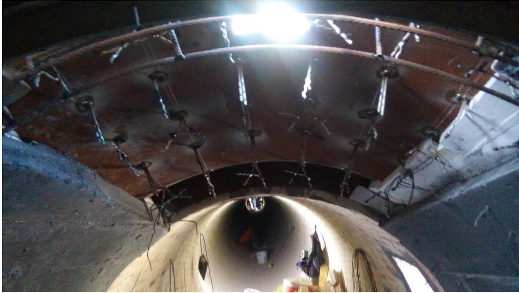
Fig. 2 Anclaje para colocación de acero. (Fuente: Fotografía propia)
