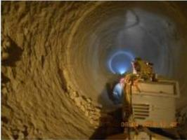
12:40 Comienza con demolición de ladrillo la máquina Brook en el interior del horno, quedándose el operador y su vigía sin ir a comer.
