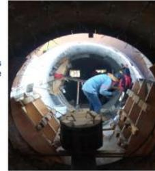
Colocación de cimbra y colado de 78 bultos de concreto CARSIT M10 en la zona de conexión de DAT con precalentador.
