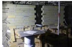
Colocación de material aislante y anclaje en muros laterales y entrada al horno.
