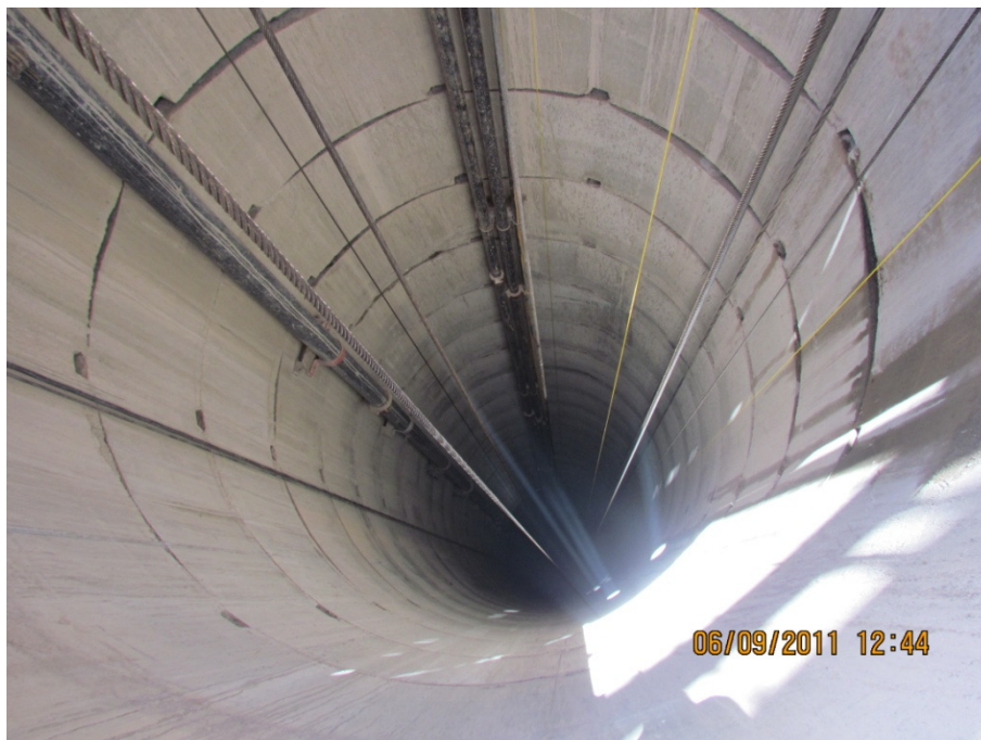
Fotografía 9. Vista del contrapozo Robbins de ventilación #8.
