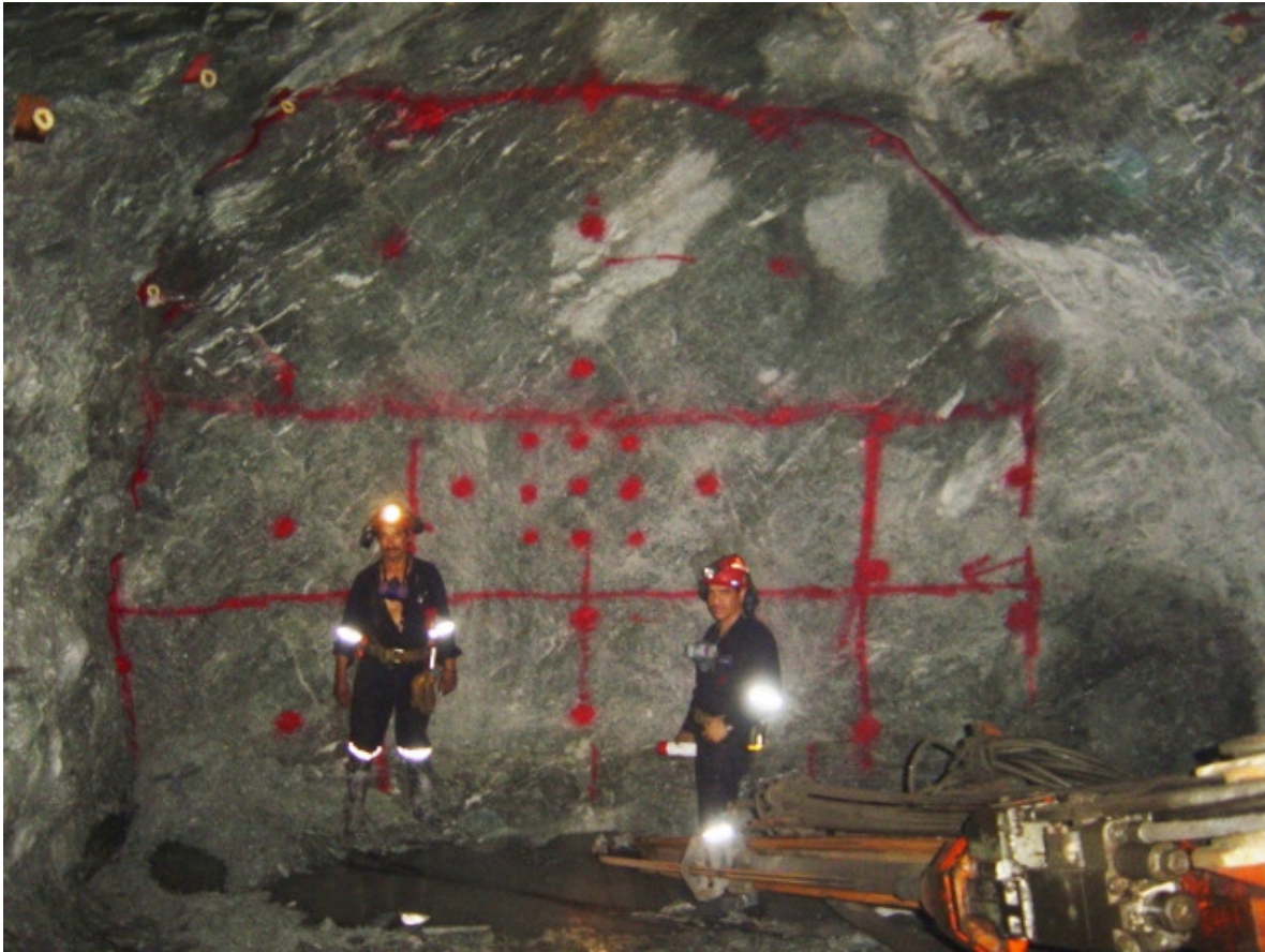
Fotografía 30. Marcación de la plantilla de barrenación en los desarrollos con la profundidad de 20 pies.
