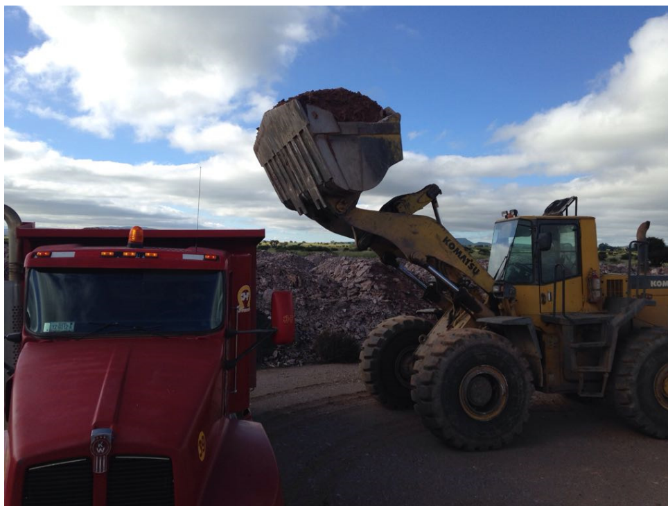
Fotografía 5. Cargado de tepetate en superficie.
