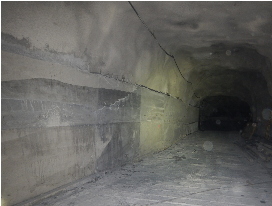
Fotografía 18. Sistema de soporte instalado en el área del taller en el nivel 890.
