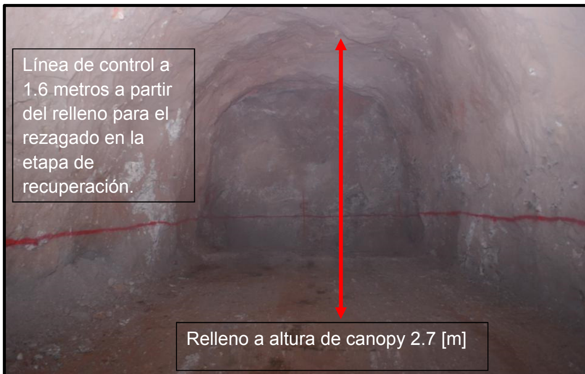
Fotografía 28. Marcaje de las líneas de rezagado en los rebajes de producción en Unidad Milpillás.
