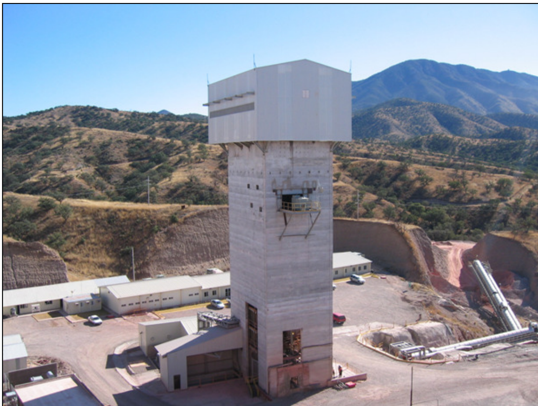
Fotografía 3. Vista panorámica del tiro Santa Cruz unidad Milpillás.
