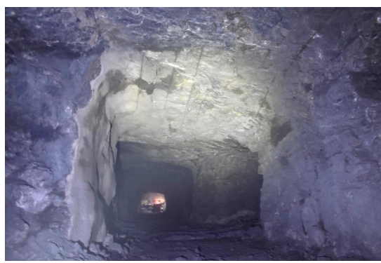
b) Voladura y barrenación controlada y soporte oportuno
