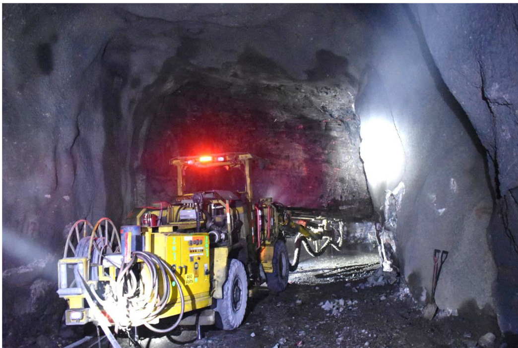
Fotografía 4. Barrenación con jumbo con barra de 16 pies, en el rebaje 60 SE. Compañía Minera La Parreña S.A de C.V Unidad Milpillás
