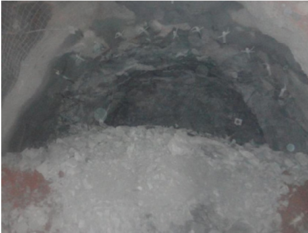
Fotografía 16. Resultados obtenidos en la operación del método de sostenimiento llamado en la Unidad Milpillas “Paraguas”
