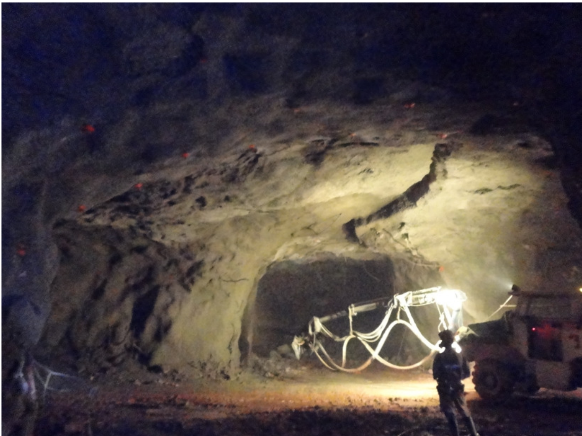
Fotografía 20. Lanzado de concreto en los rebajes de producción en el nivel 830.
