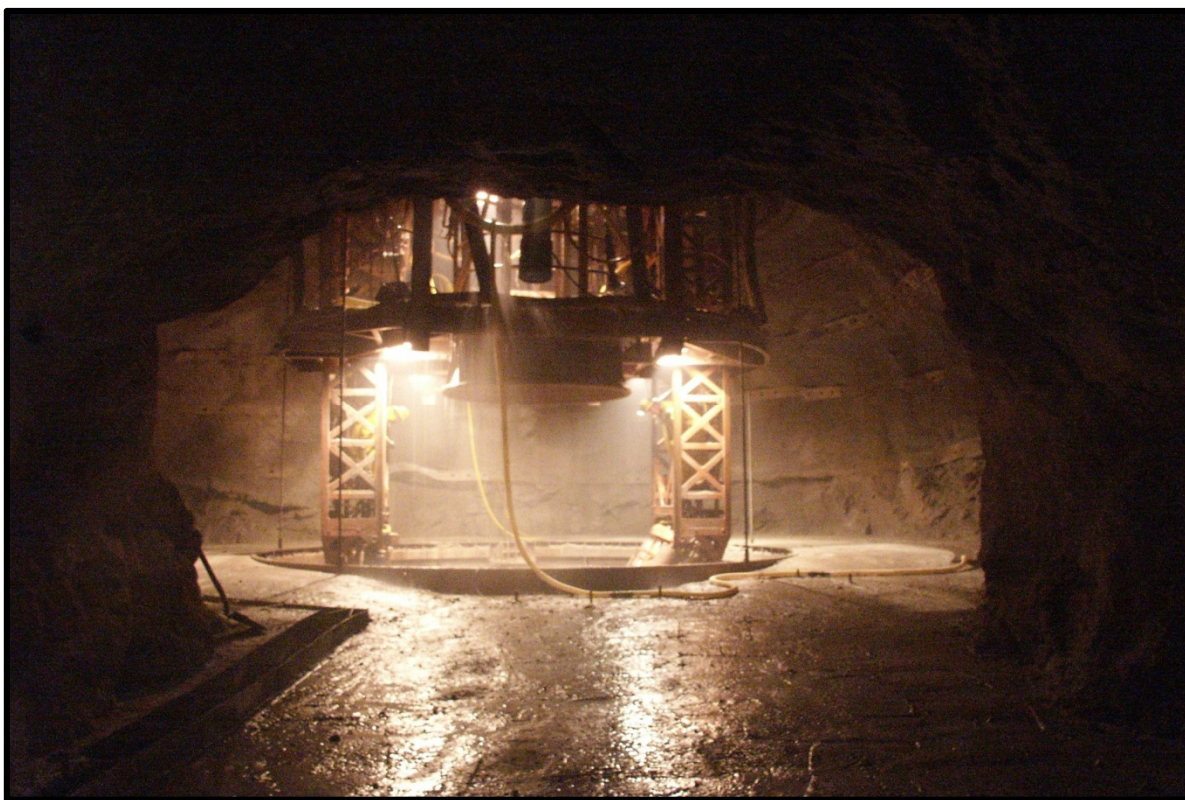
Fotografía 2. Preparación del Tiro Santa Cruz con una profundidad de 580 metros, la cual se llevó a cabo en el año 2002.
