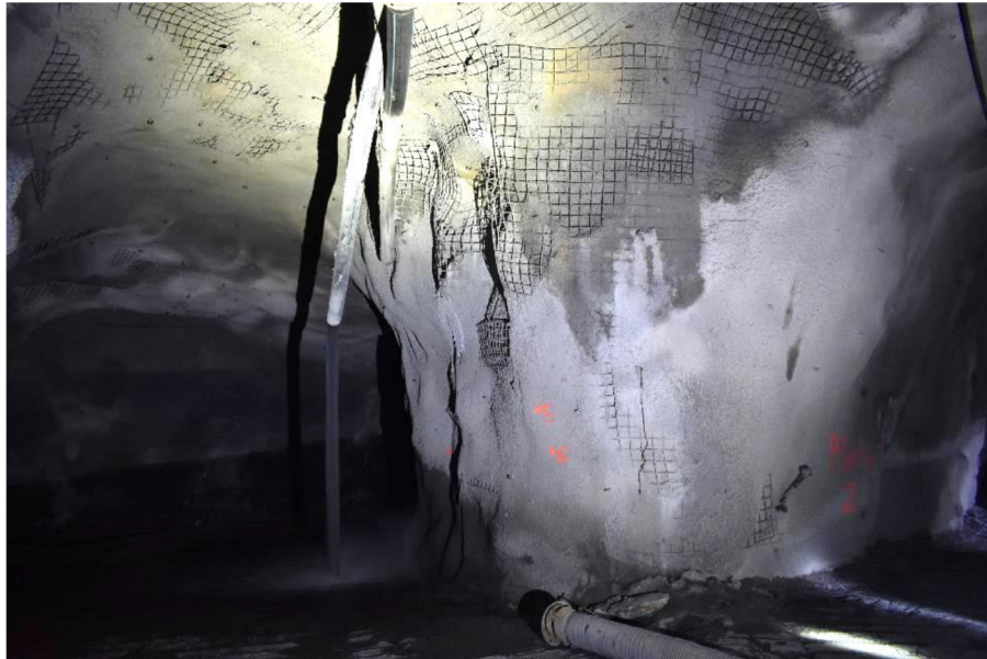
Fotografía 14. Colocación de la malla en las piletas del nivel 910.
