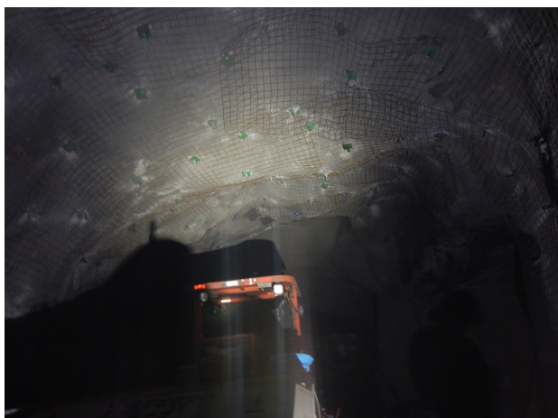
Fotografía 12. Instalación de anclaje de varilla corrugada de 9 pies de longitud y \frac{3}{4} de pulgada.
