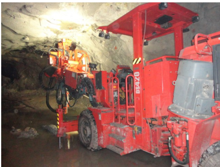
Fotografía 17. Instalación de cable de \frac{3}{4} de pulgada con una longitud de 8 metros con sección de 1.5 X 1.5 metros en el área del taller Nivel 890.
