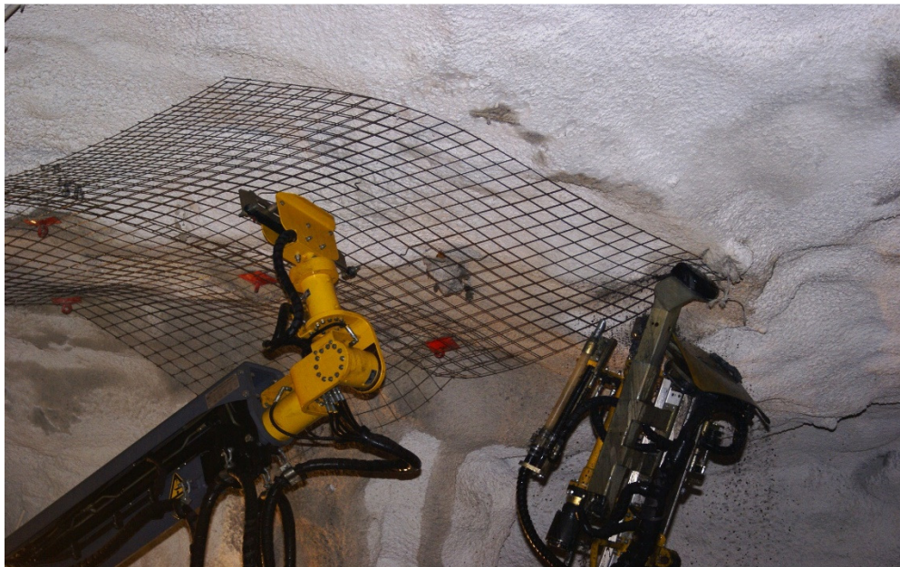
Fotografía 13. Instalación de malla ciclónica en los desarrollos de Milpa Profundo.
