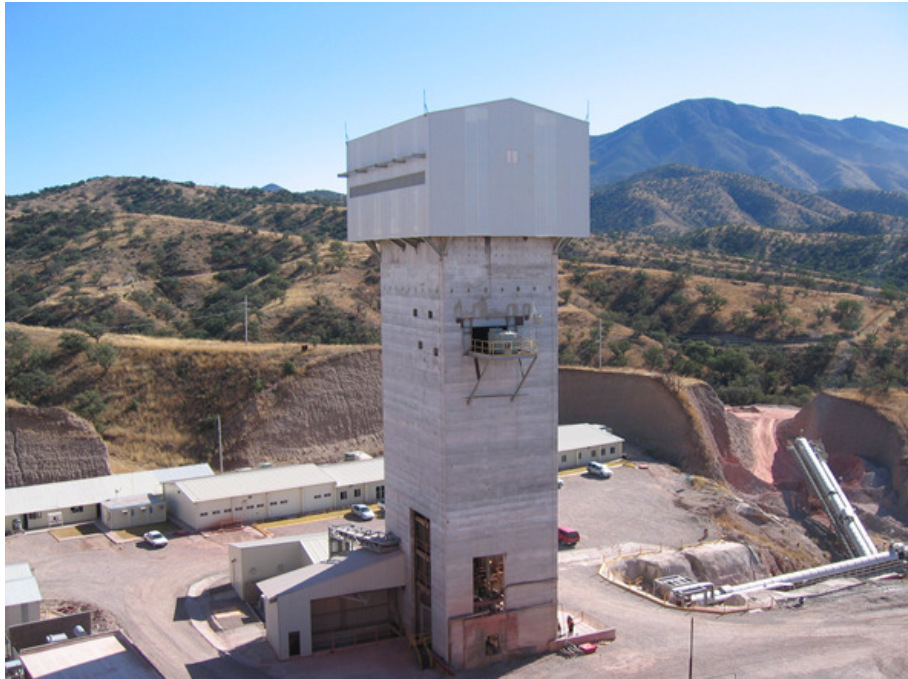
Fotografía 23. Vista del tiro Santa Cruz.
