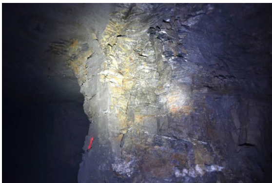
a) Roca maltratada por barrenación y voladura
