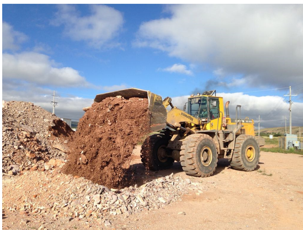
Fotografía 6. Vaciado de tepetate utilizado para el relleno de rebajes desde superficie a través de contrapozos tepetateros hacia el interior de la mina.
