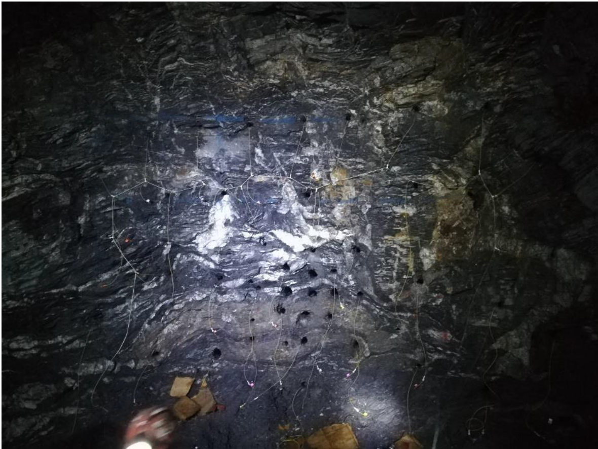
Fotografía 29. Encadenado de una voladura.
