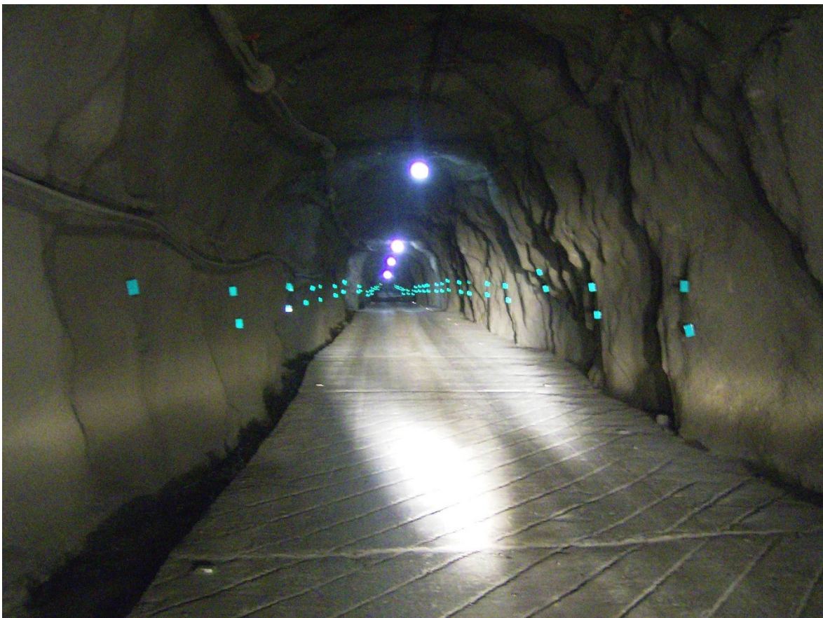
Fotografía 21. Acceso por la rampa Guadalupe al nivel 840 con sección de 6 X 5.5 metros, donde se puede ver que cuenta con acequia e iluminación en toda su longitud.
