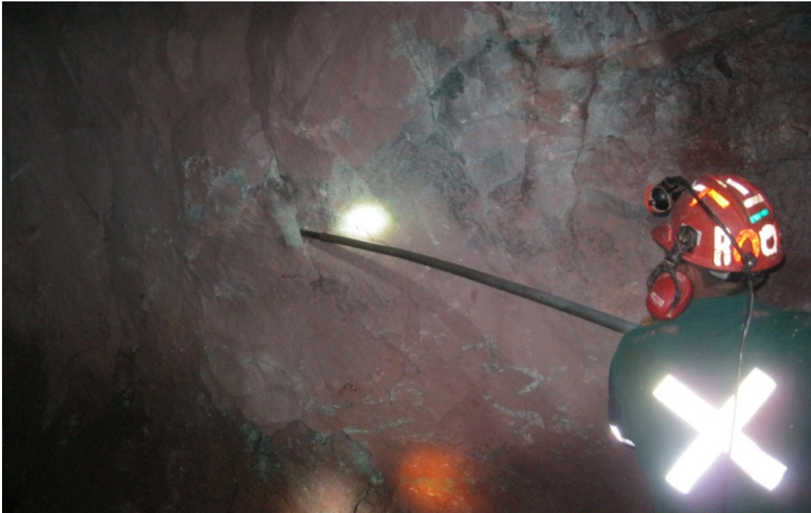
Fotografía 31. Se observa al personal ayudante del cargado de explosivo realizando la actividad del sopleteo de los barrenos para que se acople completamente el explosivo en los barrenos y lograr así una buena voladura.
