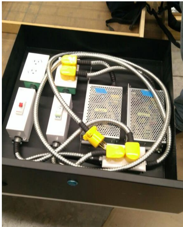
Figura 22. Ejemplo de instalación eléctrica en mobiliario utilizando interruptores termomagnéticos.
