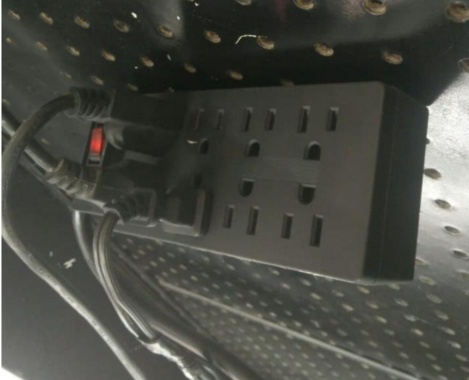
Figura 11. Alimentación de mobiliario con clavijas no polarizadas en multicontacto.
