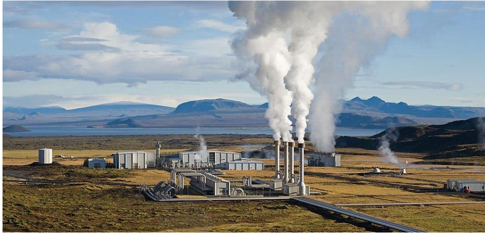
Figura 6.0: Central geotérmica de Nesjavellir, Islandia. Fuente: Gretar Ívarsson.
