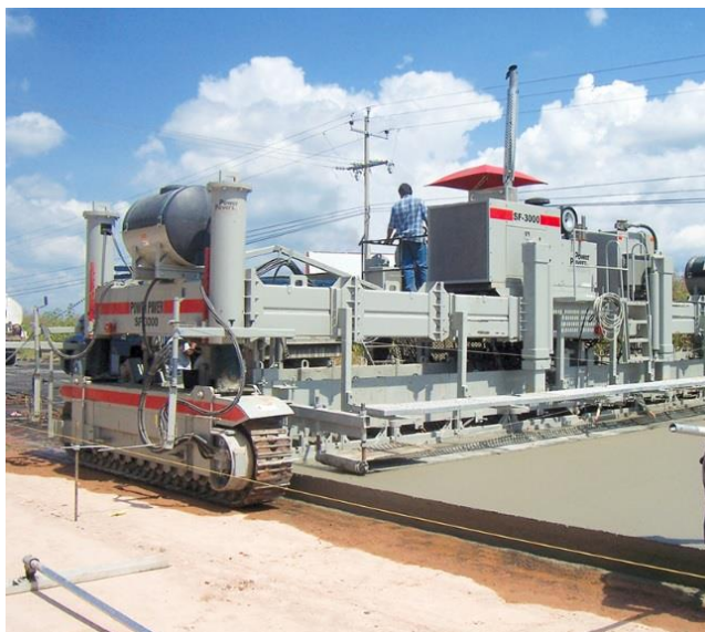
Imagen 6-7. Fase final de la colocación del concreto con pavimentadora. 68
