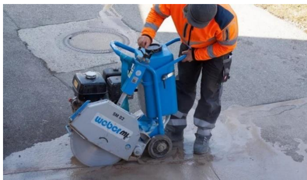
Imagen 7-15. Ranuradora de concreto. 100
