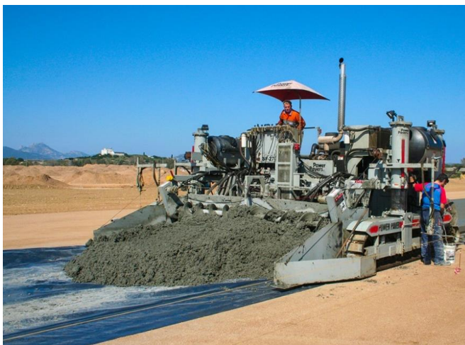
Imagen 6-6. Fase inicial de la colocación del concreto con pavimentadora. 67
