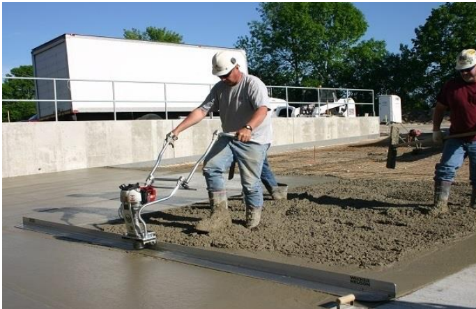
Imagen 7-4. Regla vibratoria manual. 87
