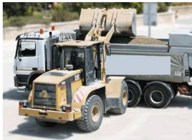
Imagen 5-6. Carga de componentes en dosificadora móvil de concreto. 53
