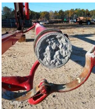
Imagen 6-17. Tubería de concreto tapada. 78
