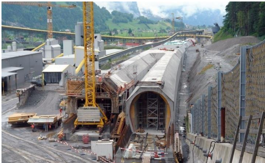
Imagen 3-6. Túnel San Gotardo. 25
