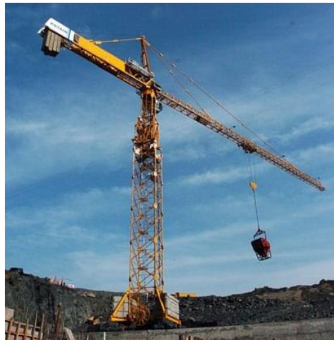
Imagen 6-11. Grúa torre para transporte de concreto, equipada con tolva. 72
