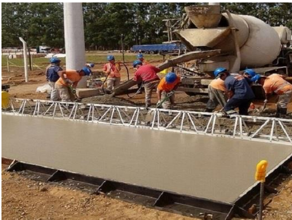
Imagen 7-5. Regla vibratoria de módulos. 88
