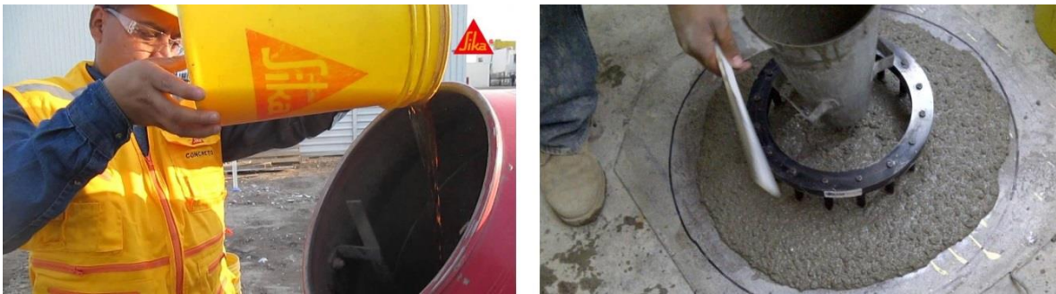
Imagen 10-2. Incorporación manual de aditivo y prueba de extensibilidad para concreto autocompactable. 109
