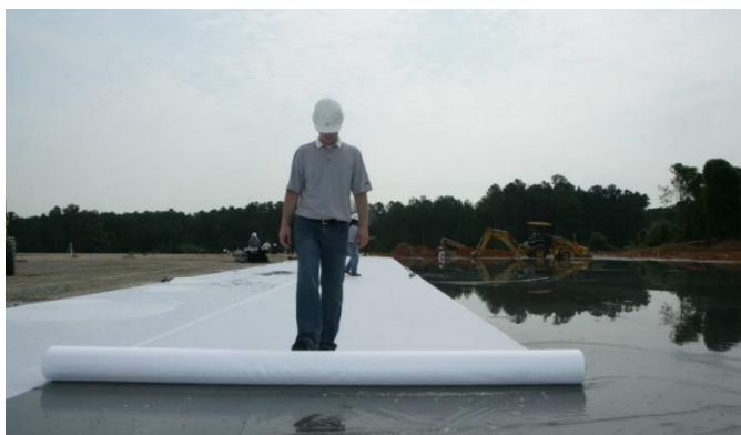
Imagen 7-11. Curado con membrana. 94
