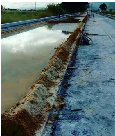
Imagen 7-9. Curado por inundación. 92
