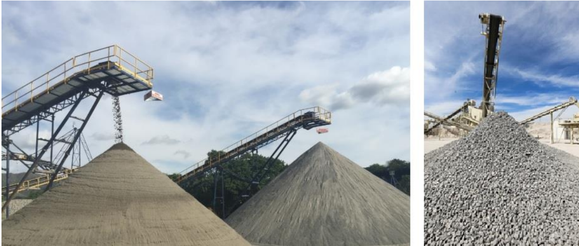
Imagen 2-1. Montículos de agregado fino y grueso. 16
