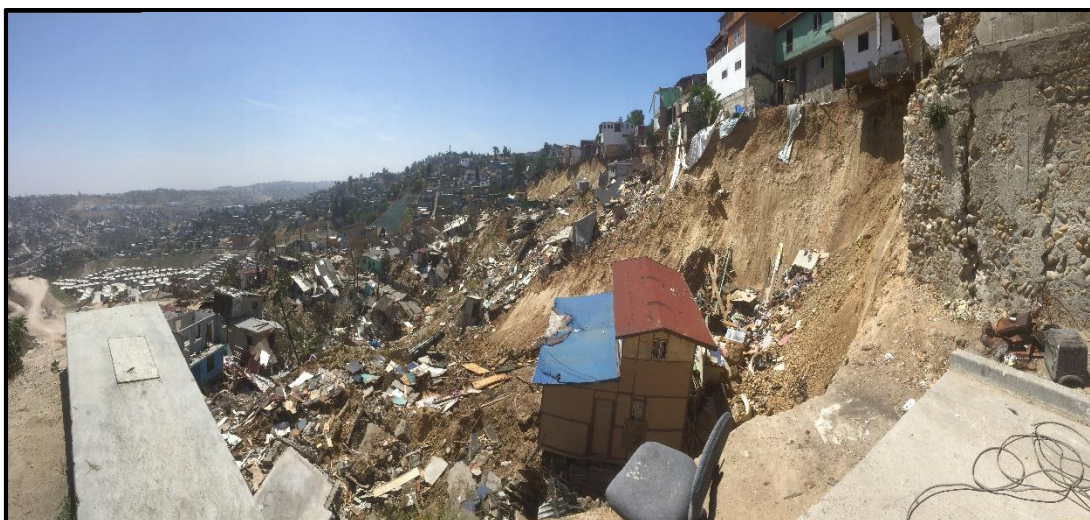
Figura 7. Daños en la colonia Lomas del Rubí (Autoría propia, junio 2018).
