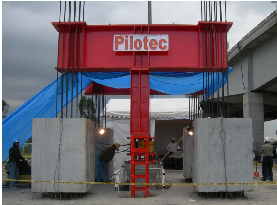
Figura 4.6 Sistema de reacción, Viaducto Carlos Hank González, Circuito Exterior Mexiquense, (Pilotec, 2007)
