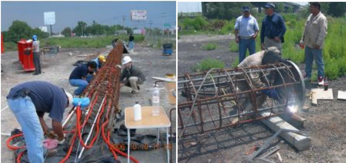
Figura 4.9 Colocación de la instrumentación en el cuerpo de la pila y la instalación de la celda de carga en la punta, cortesía de Pilotec.
