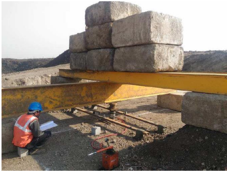
Figura 4.3 Plataforma con lastre, pruebas de carga en pilotes, GERDAU CORSA.
