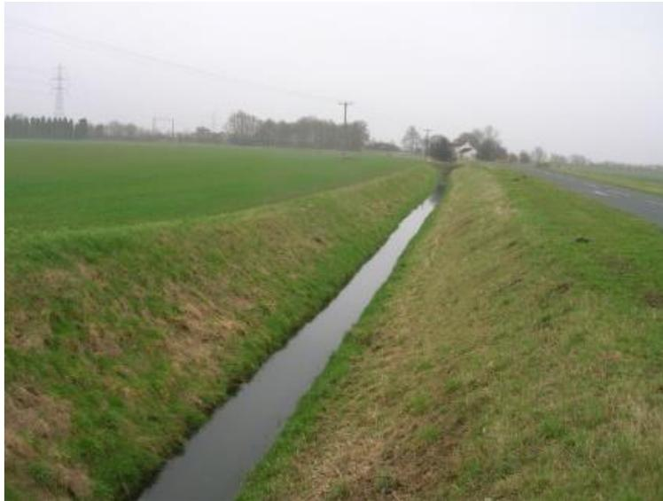
Figura 9. Canal no revestido
