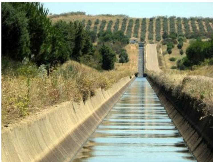
Figura 10. Canal con revestimiento de concreto
