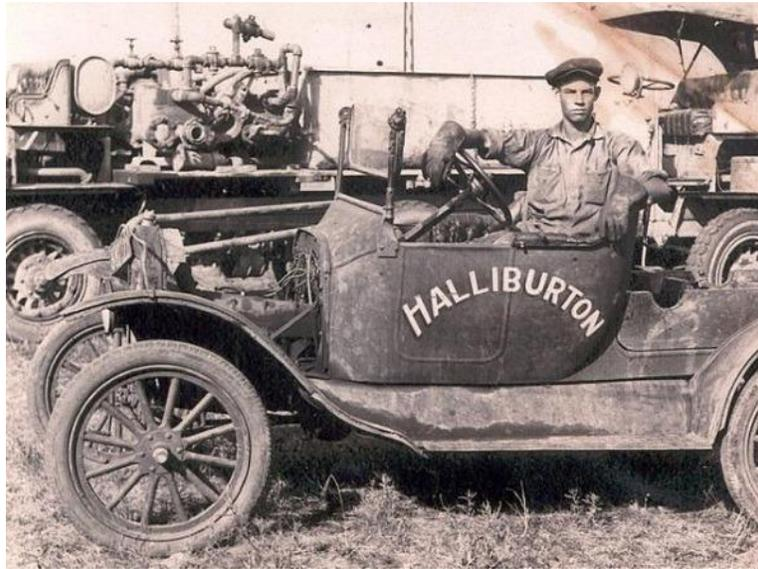
*Figura 1.* Equipo de bombeo utilizado para acidificaciones compañía cementadora Halliburton, 1921.
