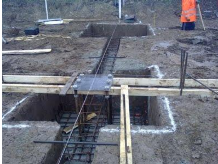
Imagen 7.1 Habilitado de refuerzo en trabes de liga y dados para la cimentación de un Rack
