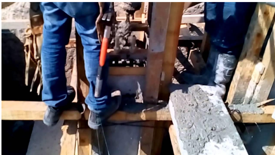
Imagen 7.2 Colado monolítico de la cimentación para un Rack de Tuberías
