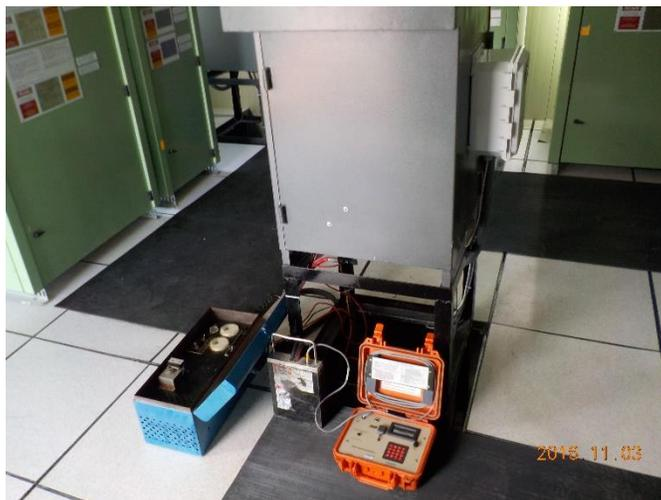
Se dejaron fuera de operación los rectificadores de protección catódica Camargo y los Ramones que protegen la línea regular y se instalaron rectificadores portátiles temporalmente, debido a que presentan problemas con la regularización de los taps o derivaciones finas del transformador del 1-4 (no drenan corriente) en modo estándar. Cabe mencionar que la corriente de salida de los rectificadores instalados temporalmente se usó con los mismos parámetros de operación normal.
