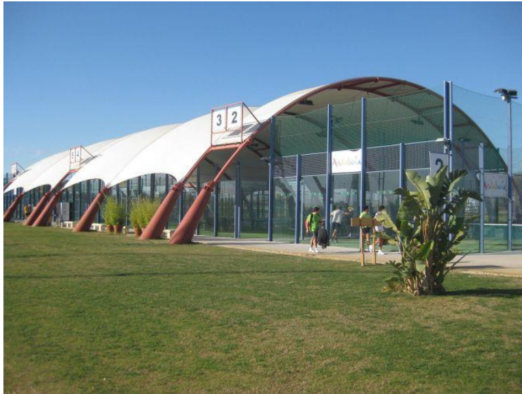
Figura 10. Cubierta Pistas Padel La Cartuja (España) 10
