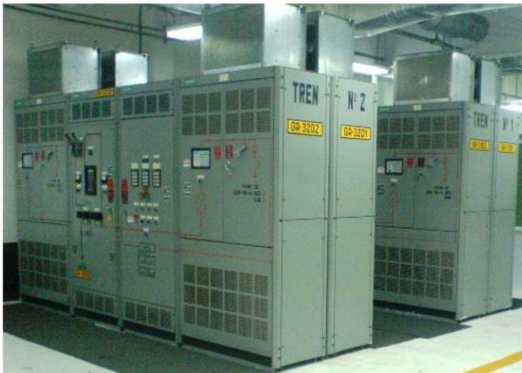
**Figura 1.1.** Sistema de transferencia Relcon™
