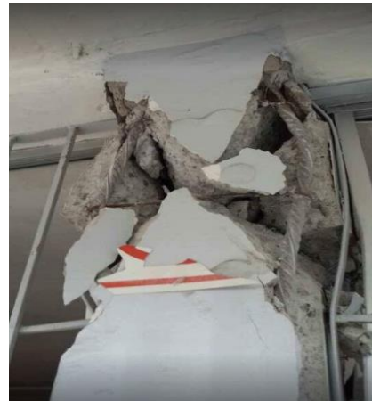
Figura 10 Escuela Secundaria Técnica No. 17: a) acceso principal al plantel, b) daño estructural en una columna del plantel (Google Maps ,2017a)
