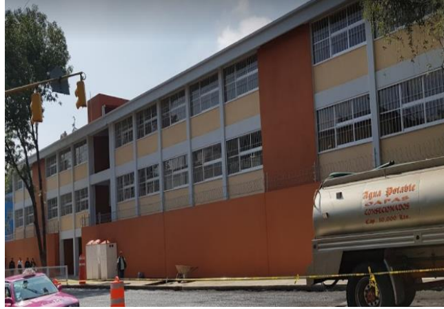
Figura 11 Nuevo plantel construido posterior al sismo del 19 de septiembre de 2017 (Google Maps, 2018b).
