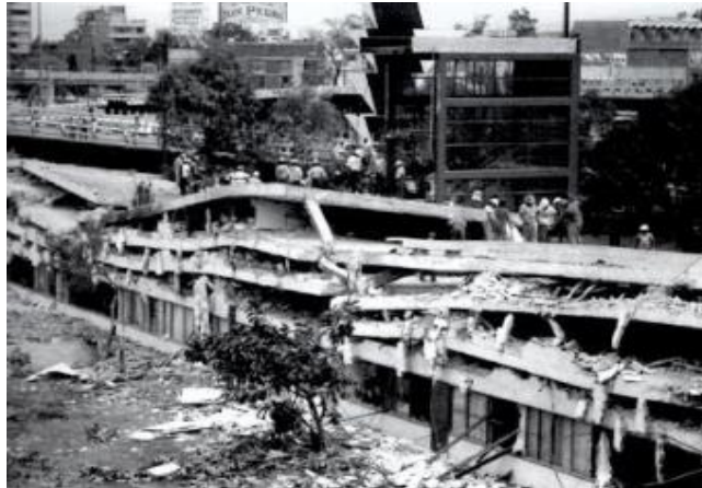
Figura 5 Edificio de Mayores después del Sismo del 19 de septiembre de 1985 (modificado de Salcido, 2015).
