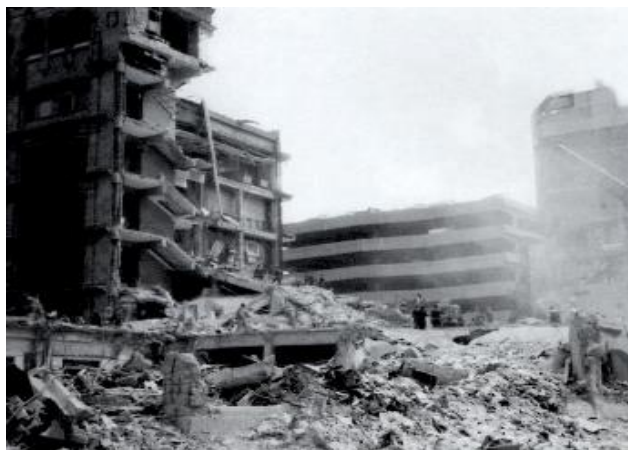
Figura 8 Conalep Humboldt, posterior al sismo del 19 de septiembre de 1985. (Salcido, 2015).
