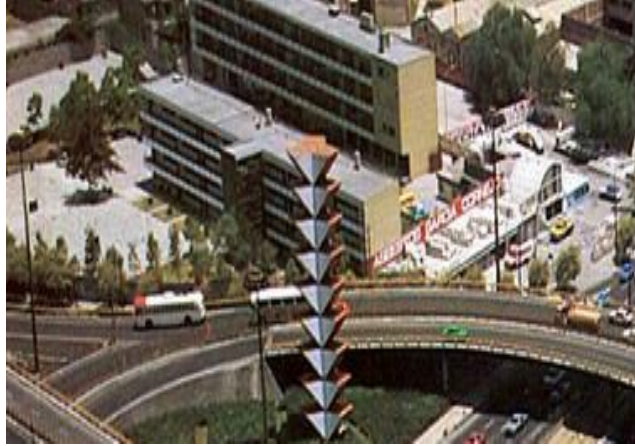
Figura 4 Foto del cruce de la calzada de Tlalpan y Miguel Ángel de Quevedo. Se aprecia los dos edificios del Instituto Cultural Teresiano (modificada de flickr, 2011).
