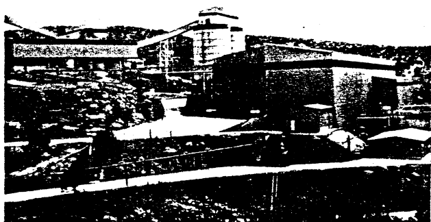
Foto 5 Aspecto general que presenta una planta de beneficio, moderna y de gran capacidad
