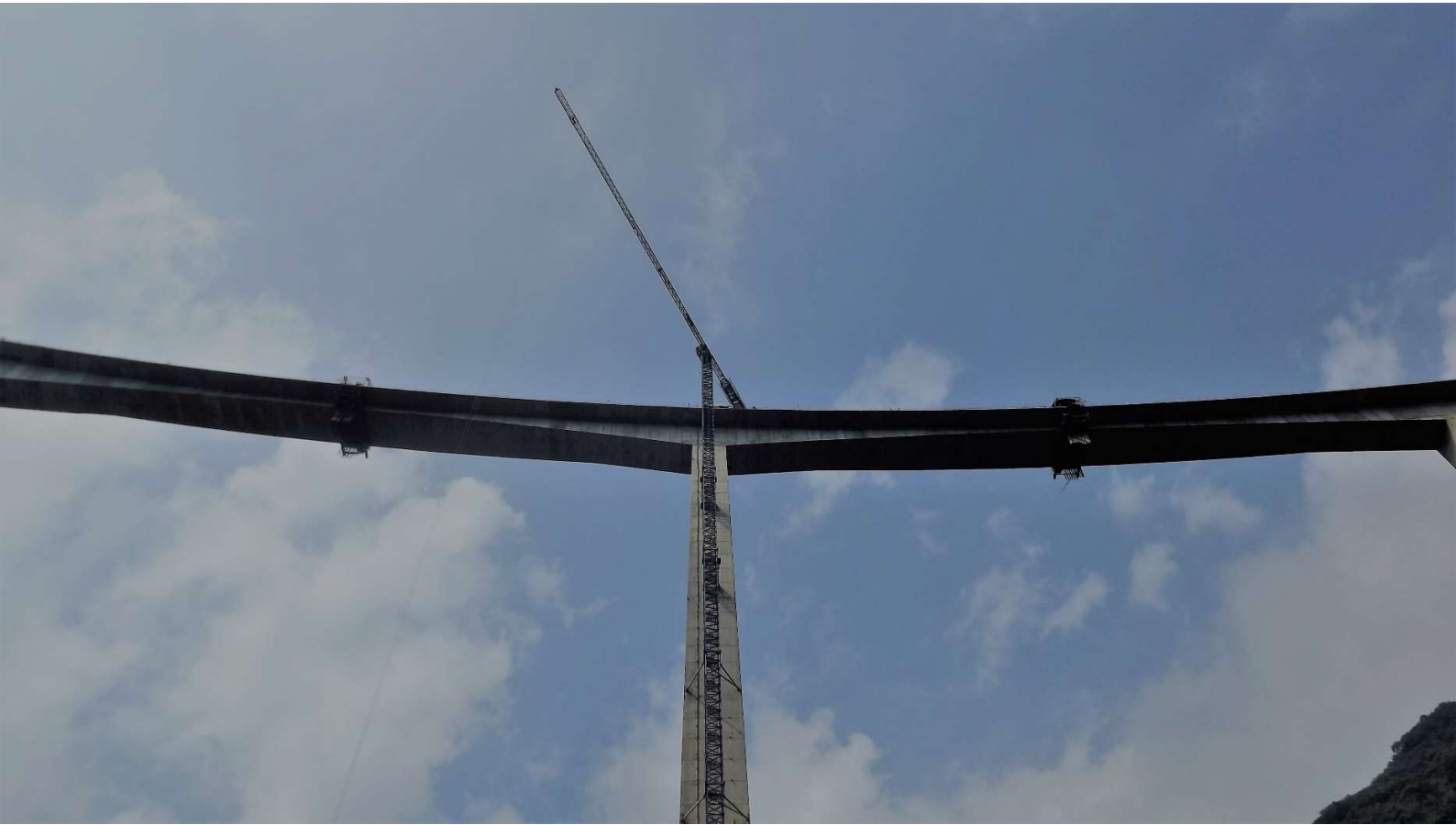
Fotografía: Puente Gilberto Borja Navarrete, Autopista Nuevo Necaxa-Tehuacán, México 2012
