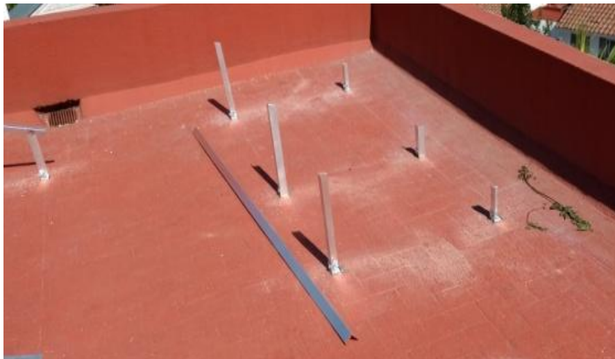
Imagen 3.4 – fijación de soportes para travesaños: aporte propio.
