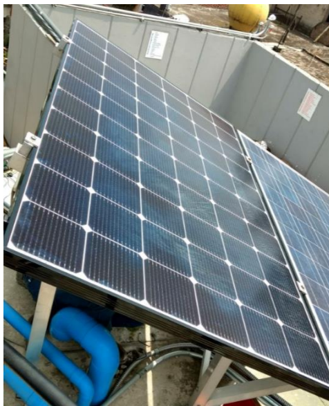
Imagen 1.1 - módulo fotovoltaico 400W: aporte propio.
