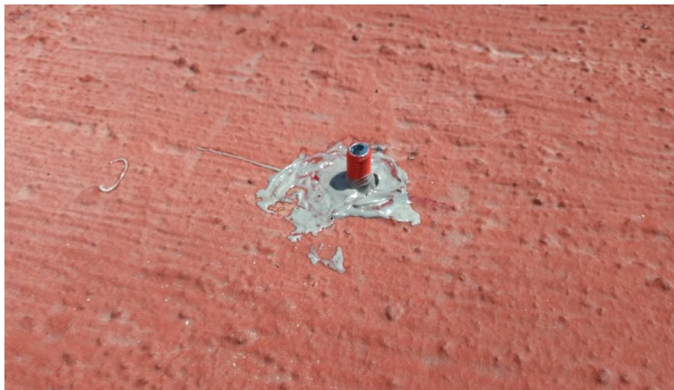
Imagen 3.1 - Anclaje a losa de concreto con resina epóxica: aporte propio.
