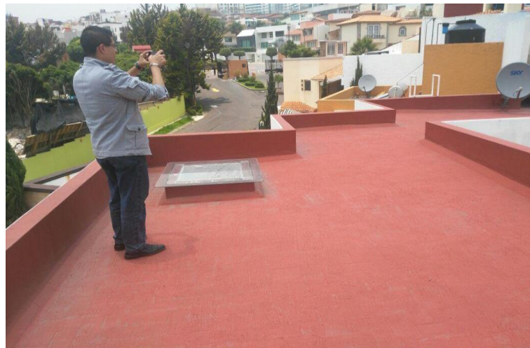
Imagen 2.4 - Fotografía del sitio, azotea: aporte propio.
