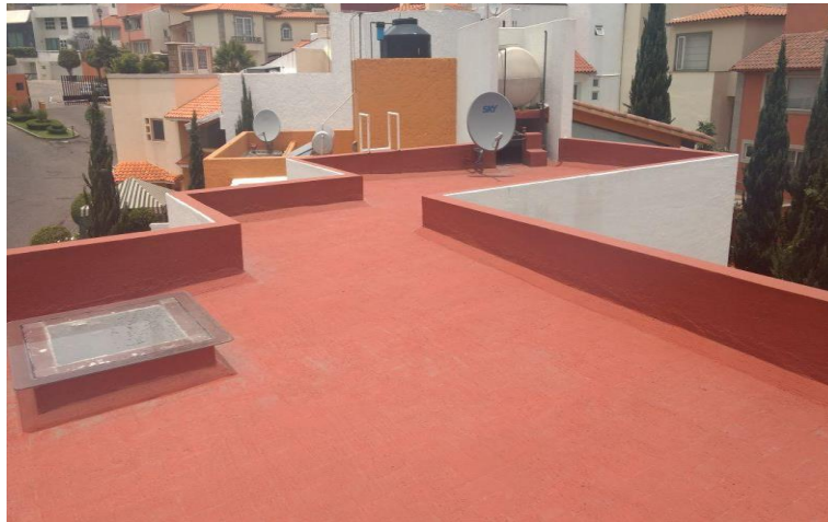
Imagen 2.3 - Fotografía del sitio, azotea: aporte propio.
