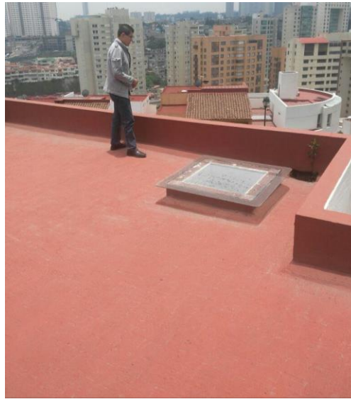
Imagen 2.5 - Fotografía del sitio, azotea: aporte propio.
