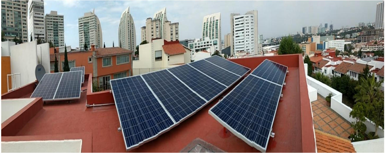
Imagen 3.16 – Montaje de módulos completo: aporte propio.
