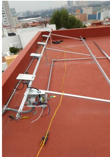
Imagen 3.13 – Montaje de microinversores del panel de 5 módulos en vertical: aporte propio.
