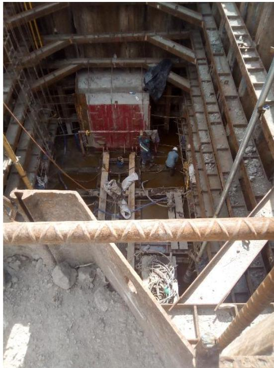
Figura 4.- Construcción de una lumbrera, mediante muros Milán (autoría propia).
