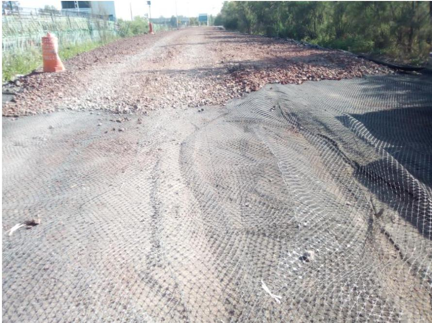
Figura 3.4.- Geomalla colocada en camino de penetración (autoría propia).
