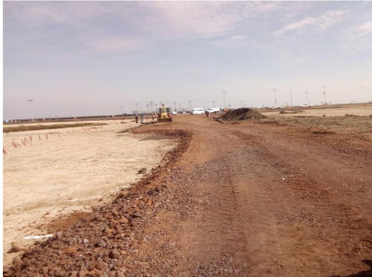
Figura 3.7.- Construcción de camino de penetración (autoría propia).
