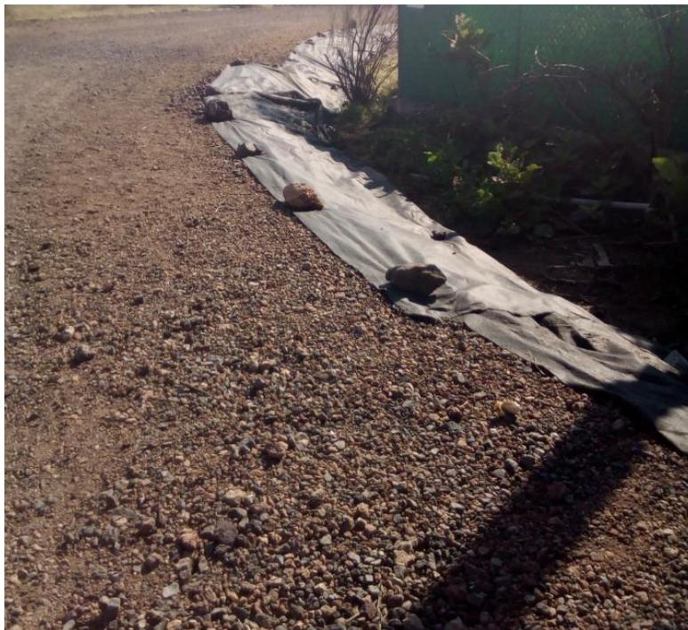
Figura 3.3.-Geotextil colocado en camino de penetración (autoría propia).
