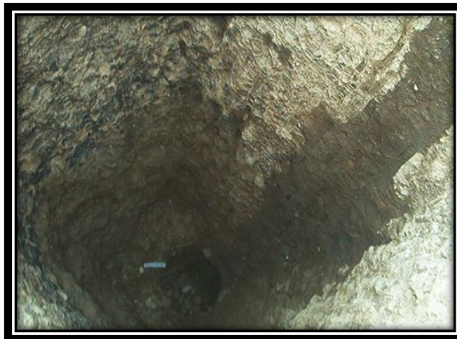
Hechura de la lumbrera para acceso a la cavidad
