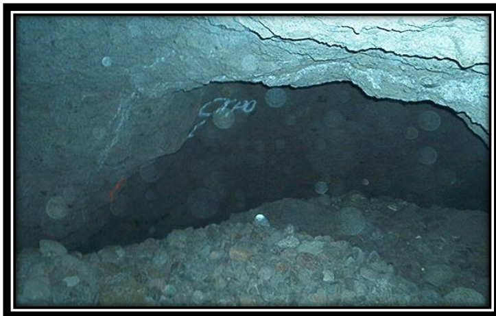
Trazo de la Caverna y material de demolición rellenado por los habitantes de la propiedad.
