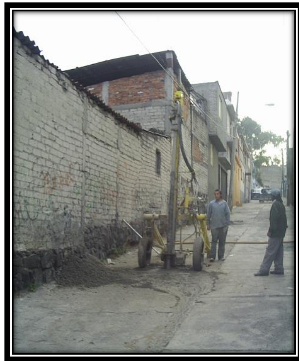
Equipo de perforacion simple neumatico
