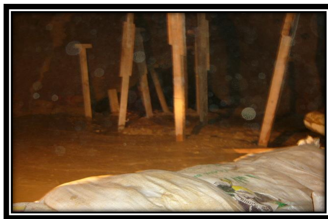
Figura 20. Relleno por bloques y relleno de fluido en la mina y apuntalamiento por la caída de bloques
