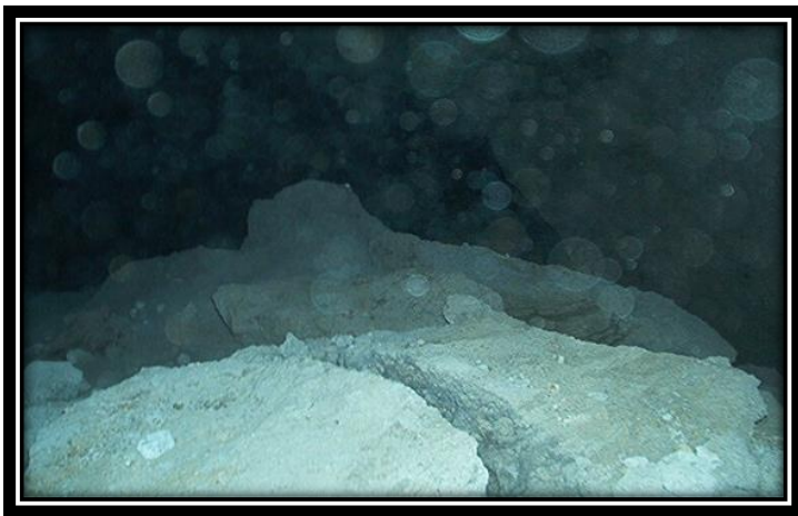
Derrumbe de los techos de una caverna inestable
