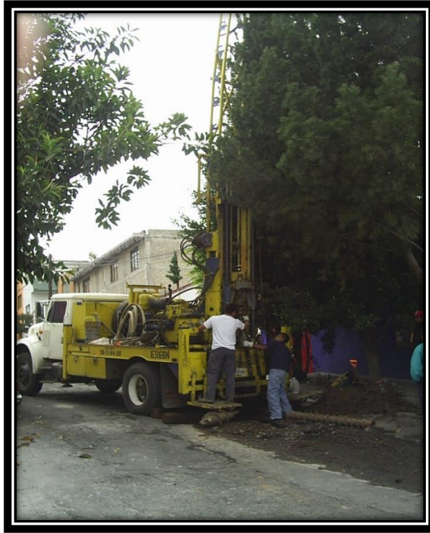
Equipo de perforacion Rotaria para la ubicacion de las cavidades de la zona.
