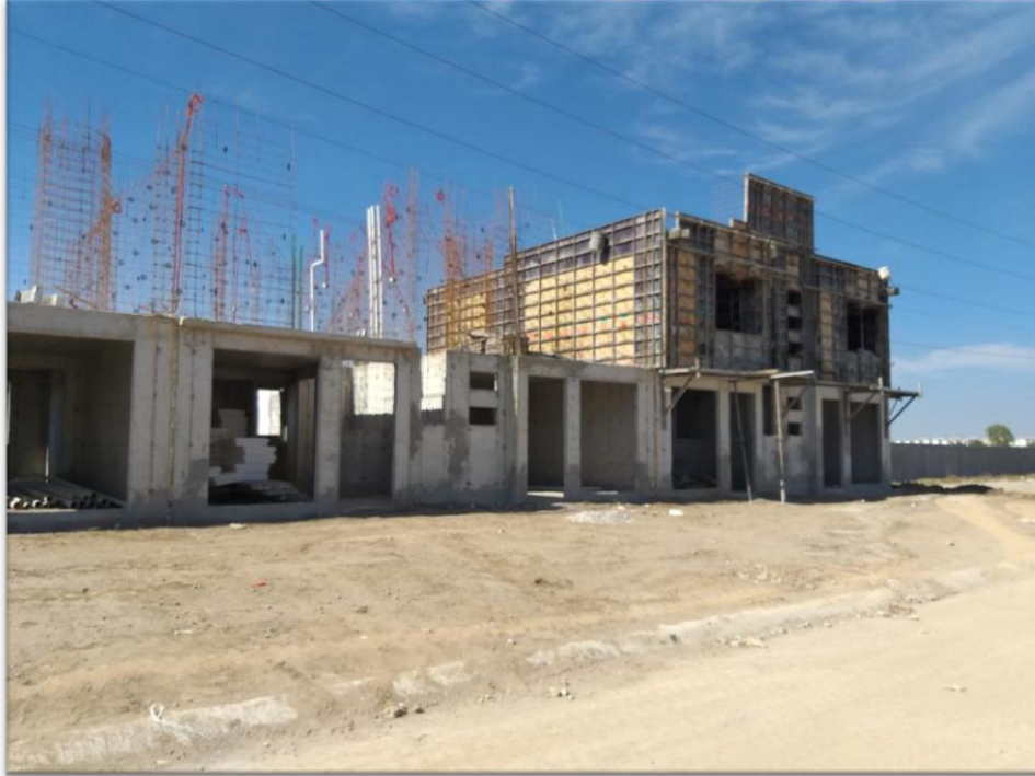
Figura No. 46 – Cimbra montada sobre segundo nivel.
