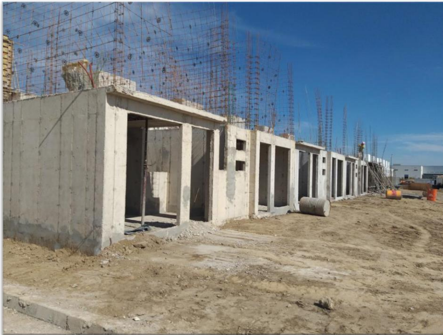
Figura No. 45 – Muros de primer nivel y continuación del armado para muros de segundo nivel.
