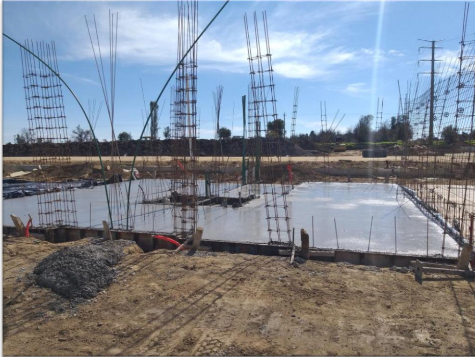
Figura No. 44 – Colado de losa de cimentación.
