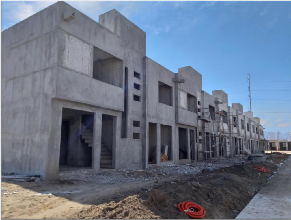
Figura No. 48 – Prototipo Ciprés Dx construcción de obra negra finalizada.
