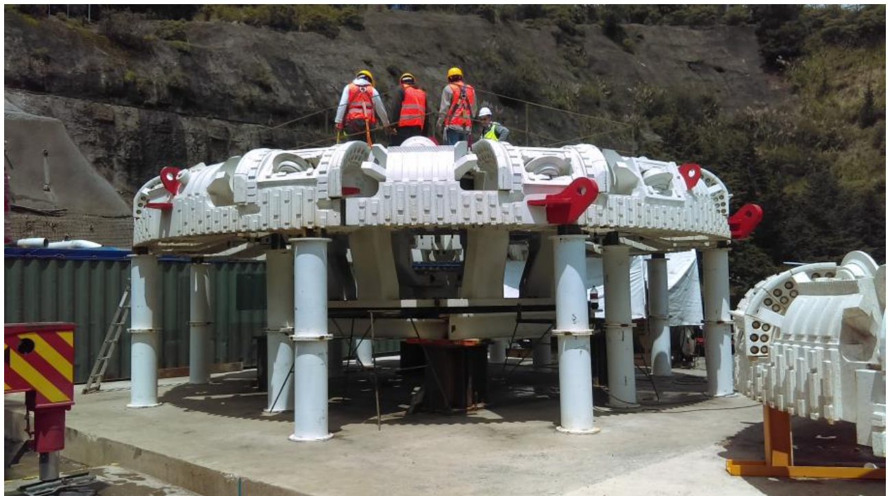
Figura 3.4 Ensamble de la rueda de corte.
