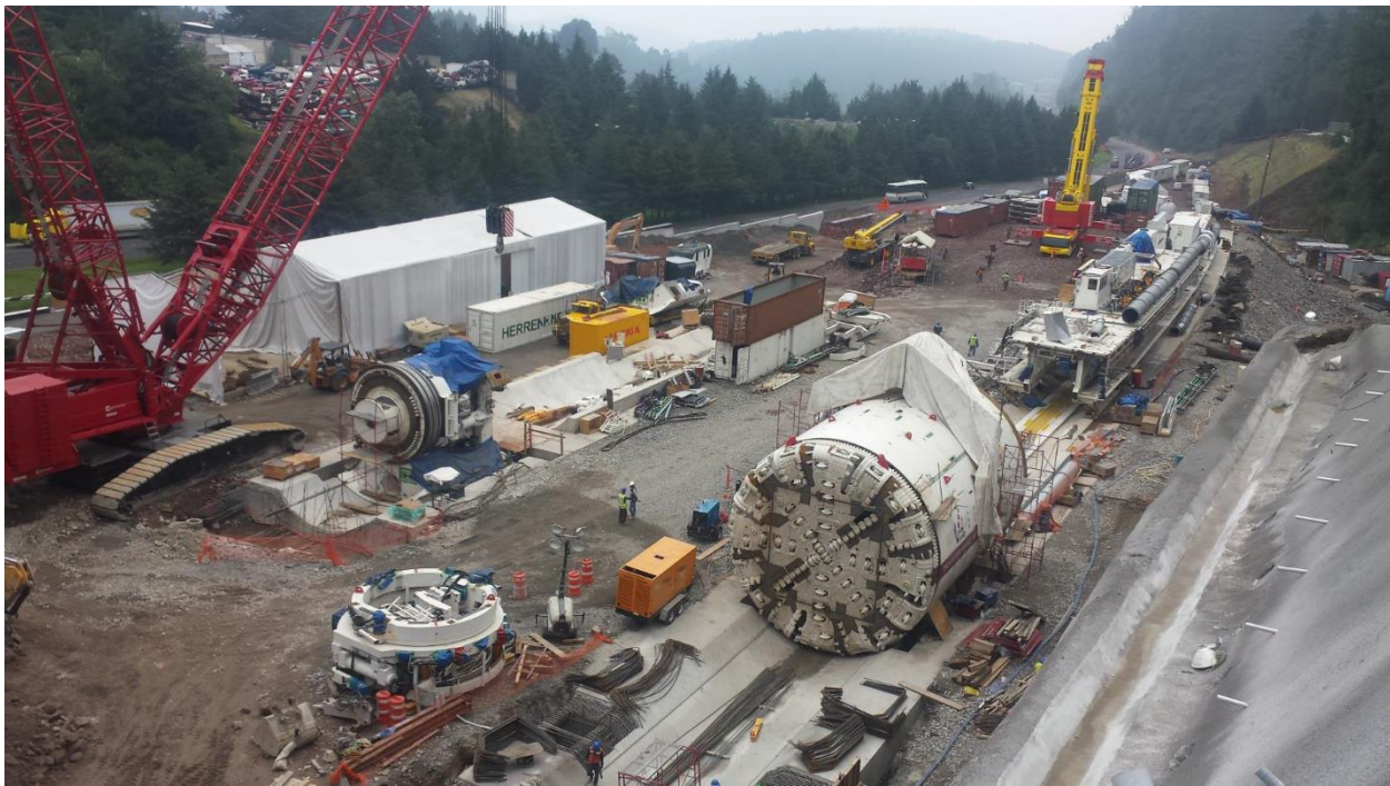
Figura 3.8 Ensamble de una de las dos tuneladoras.
