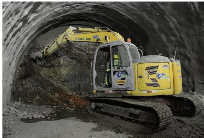
Figura 1.21 Imagen de un martillo hidráulico en operación.
