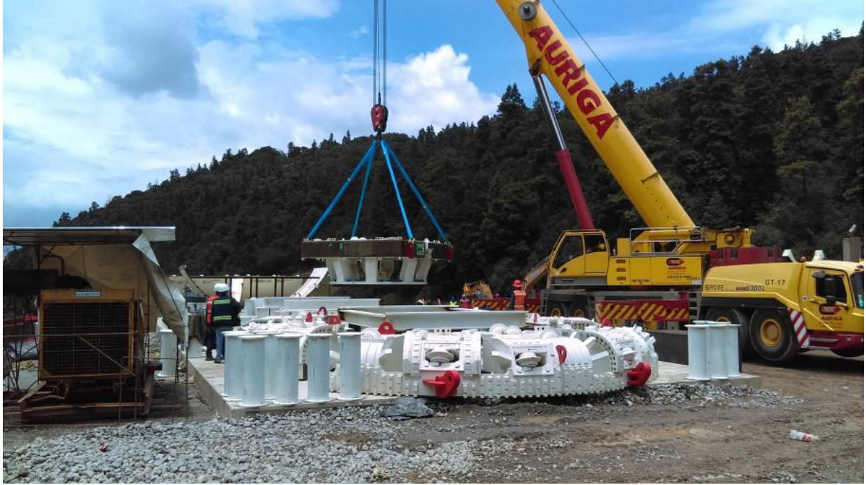
Figura 3.5 Montaje de la rueda de corte.
