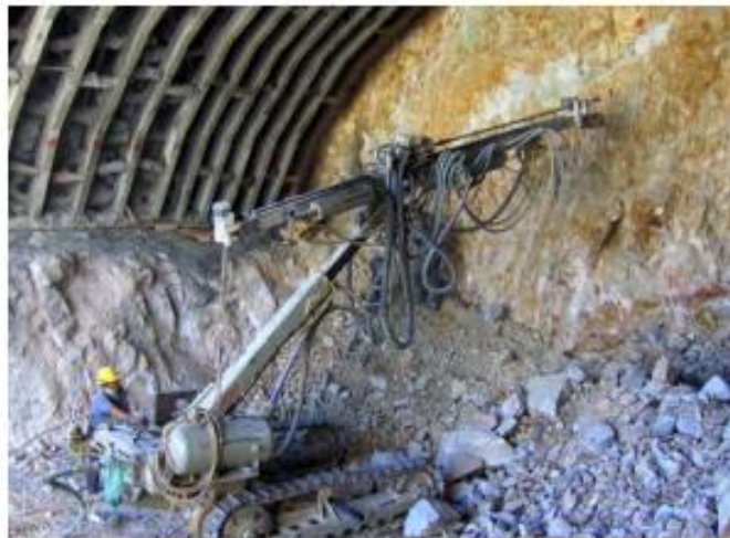
Figura 1.18 Imagen de un Track-drill en operación.
