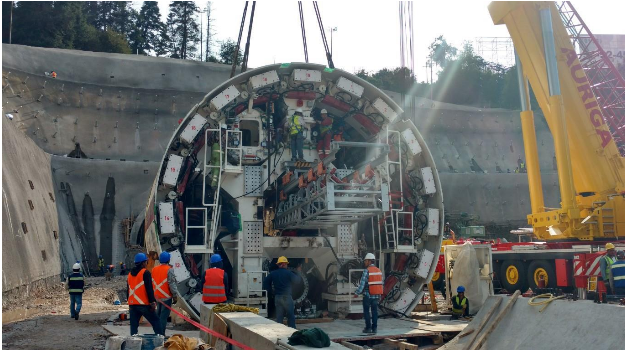
Figura 3.7 Montaje de la rueda de corte.
