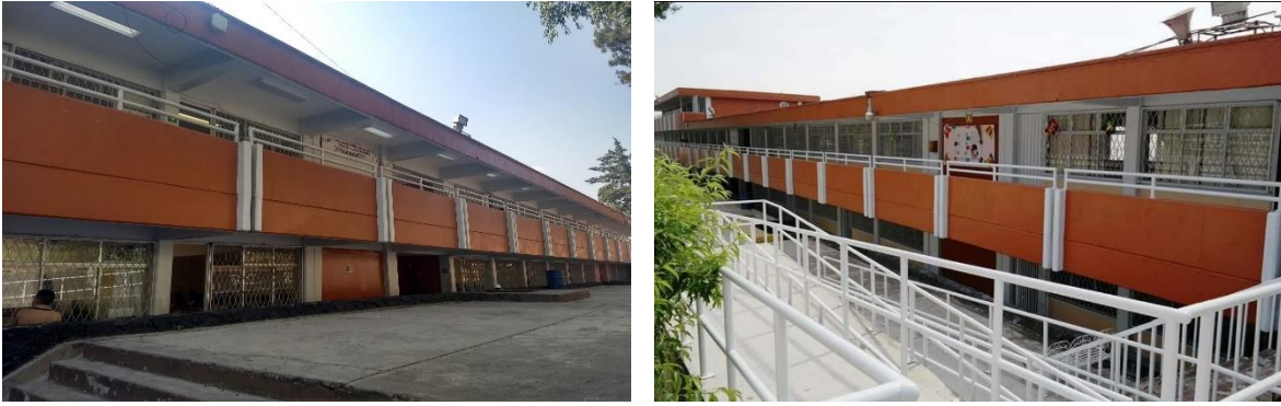
Figura 4.1 – Edificios U2C y U3C.
