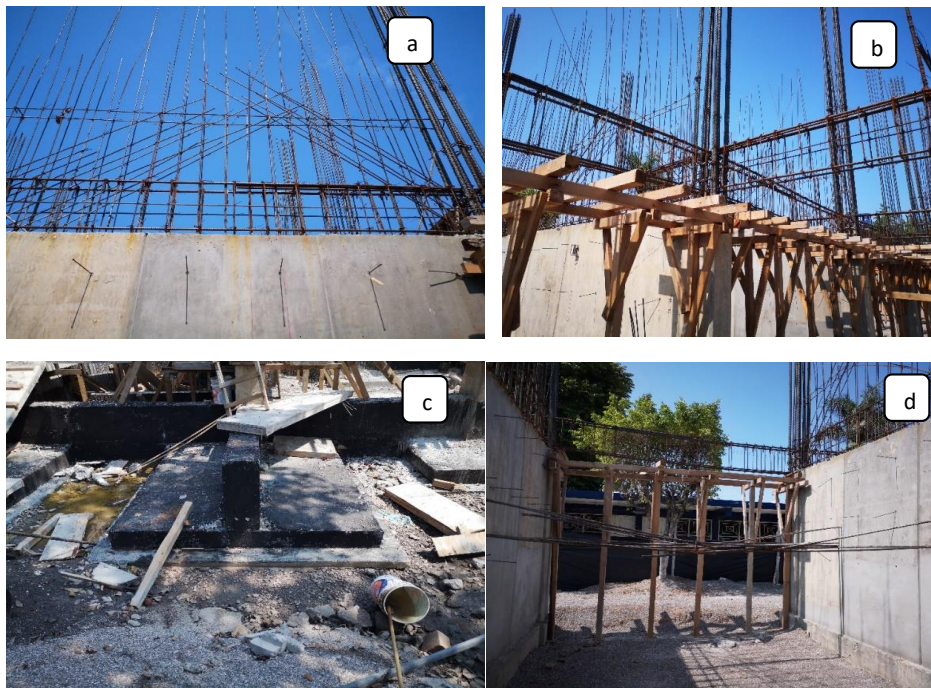
Figura 4.7 - Estado actual de reconstrucción de la escuela "Benito Juárez".
