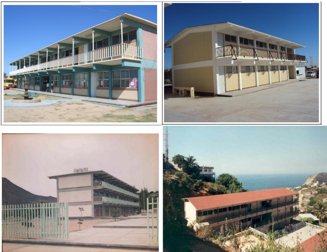
Figura 3.1 - Estructuras urbanas de concreto en sus diferentes versiones.
