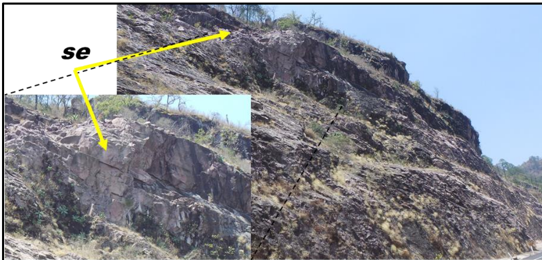
Fotografía 4.16. Vista lateral de la pseudoestratificación (se); se aprecia la orientación desfavorable hacia la vialidad
