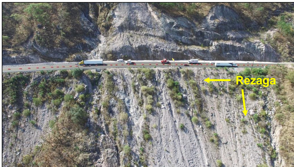
Fotografía 4.13. Depósitos de talud y volteo situados por debajo de la cota de la autopista
