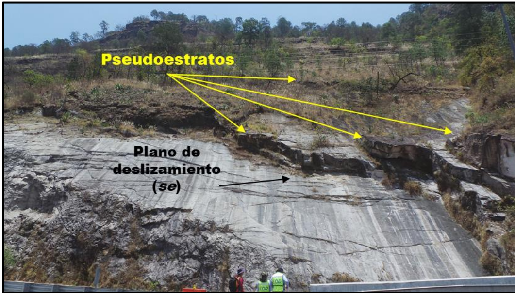
Fotografía 4.21. Zona de deslizamiento más reciente, se aprecia el plano de deslizamiento y los pseudoestratos seccionados en la parte alta
