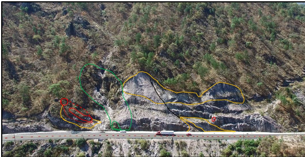
Fotografía 4.20. Panorámica que ilustra los elementos inestables en el corte hacia el extremo suroeste
