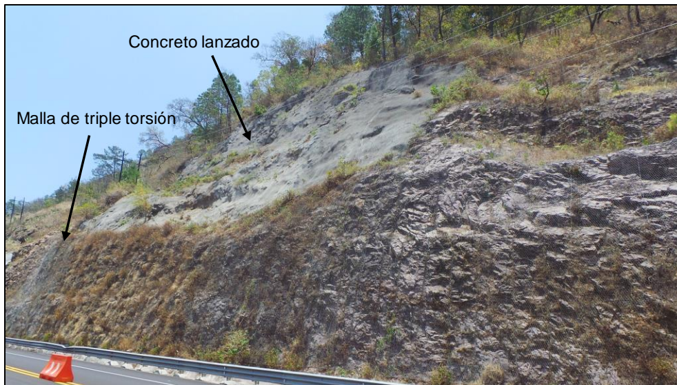
Fotografía 1.2. Porción del corte, entre los km 144+020 y 144+120; destaca la zona de concreto lanzado y malla de triple torsión.
