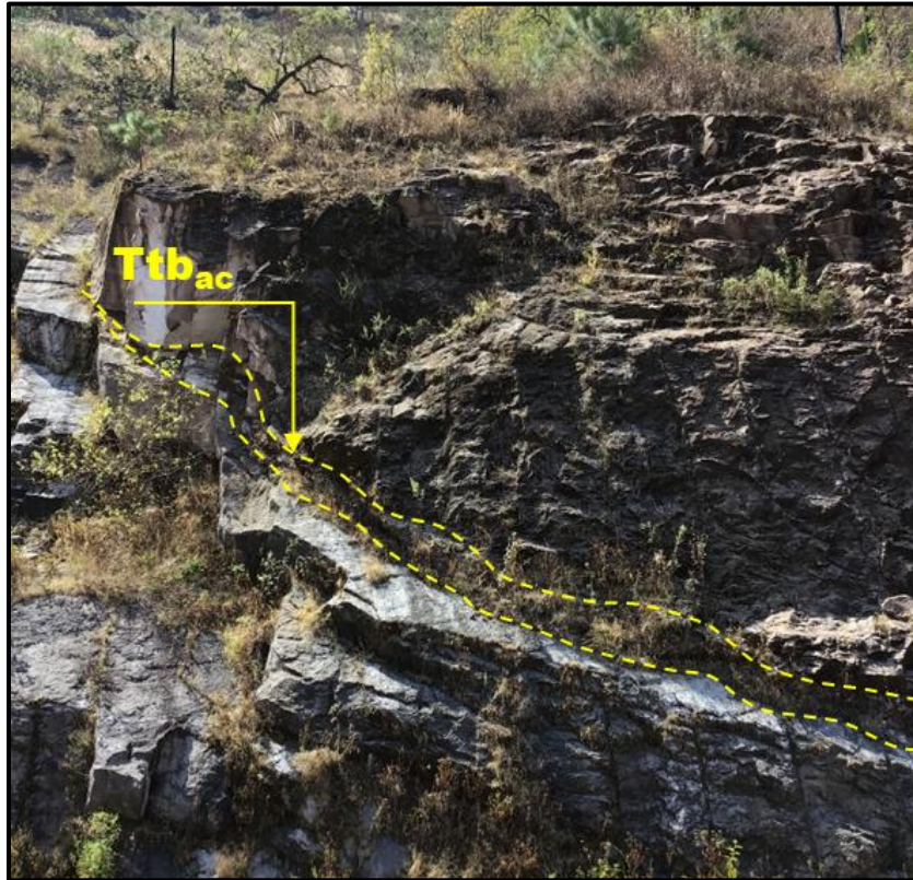
Fotografía 4.7. Estrato de toba arcillosa en las inmediaciones del Km 144+020, se observa limitado por líneas amarillas segmentadas
