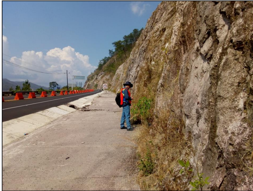
Fotografía 3.3. Valoración del macizo rocoso en el frente del talud antes de hacer en ensaye con el esclerómetro
