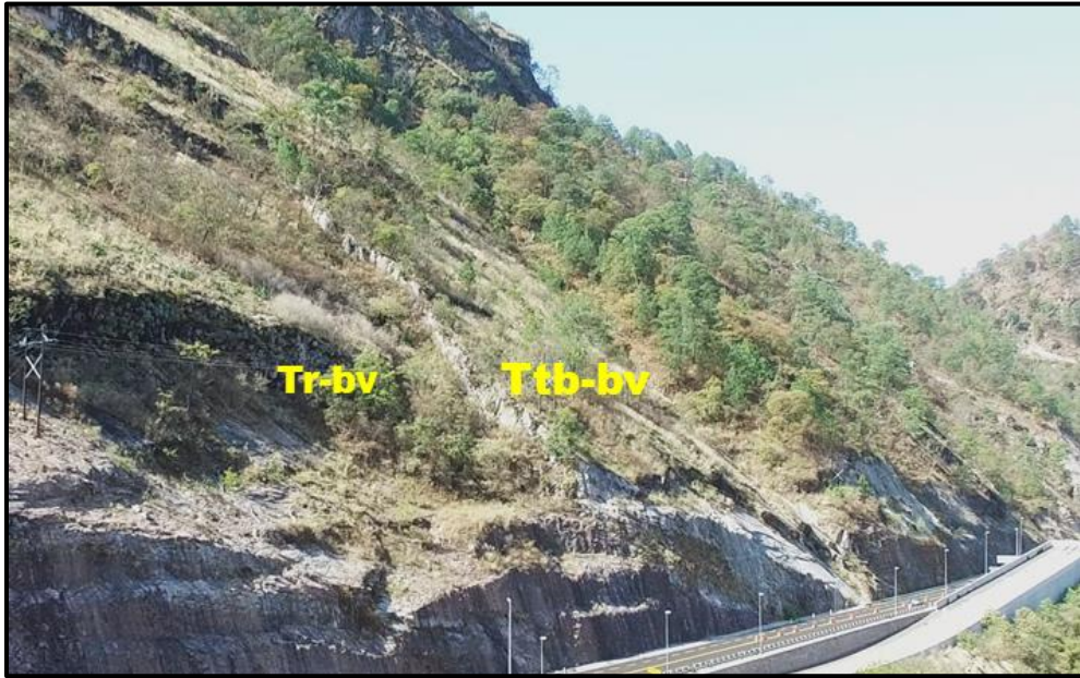
Fotografía 4.5. Vista lateral de la zona donde hay mayor presencia de la unidad Ttb-bv. Es visible la morfología y los escarpes que forman
