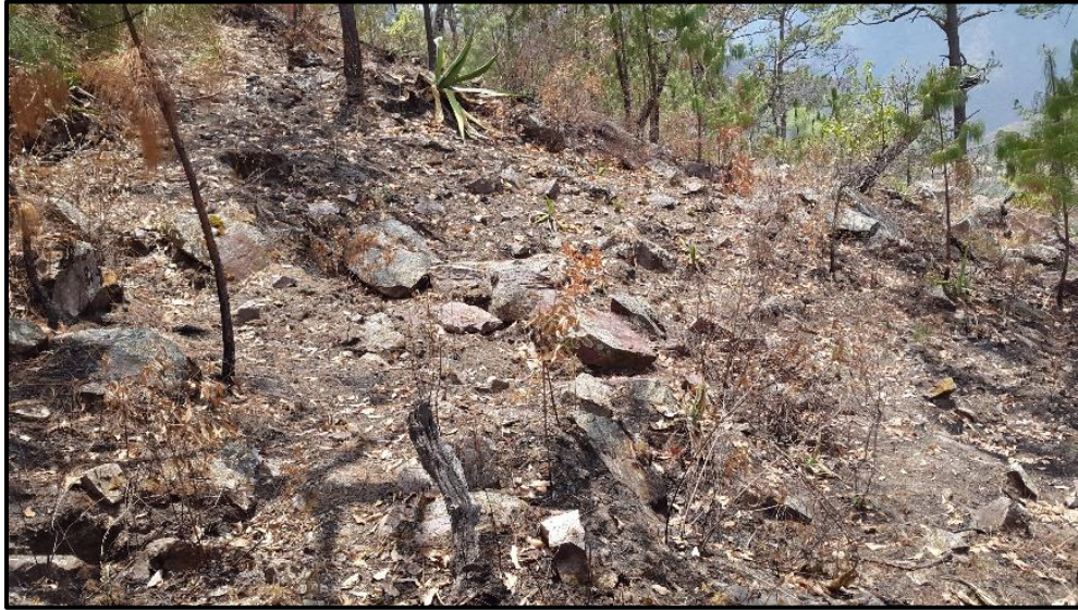
Fotografía 4.12. Depósitos de talud en ladera próxima al hombro del corte
