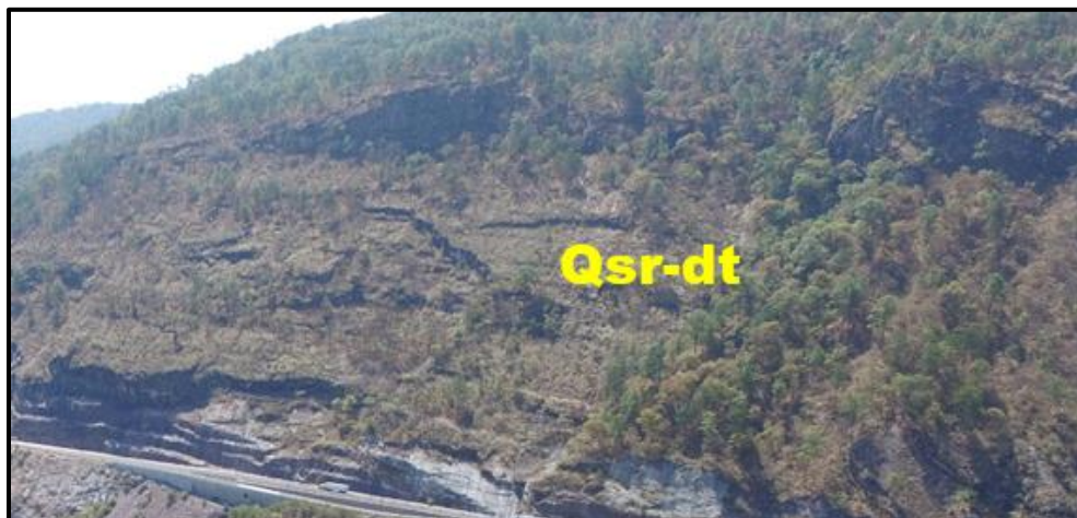
Fotografía 4.11. Vista panorámica del corte en donde se observa la cubierta de suelo y depósitos de talud en la parte superior del talud
