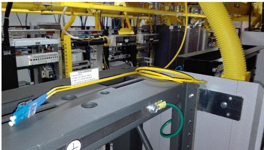
*Figura 4.7. Fibra Óptica en Rack del Cliente.*
