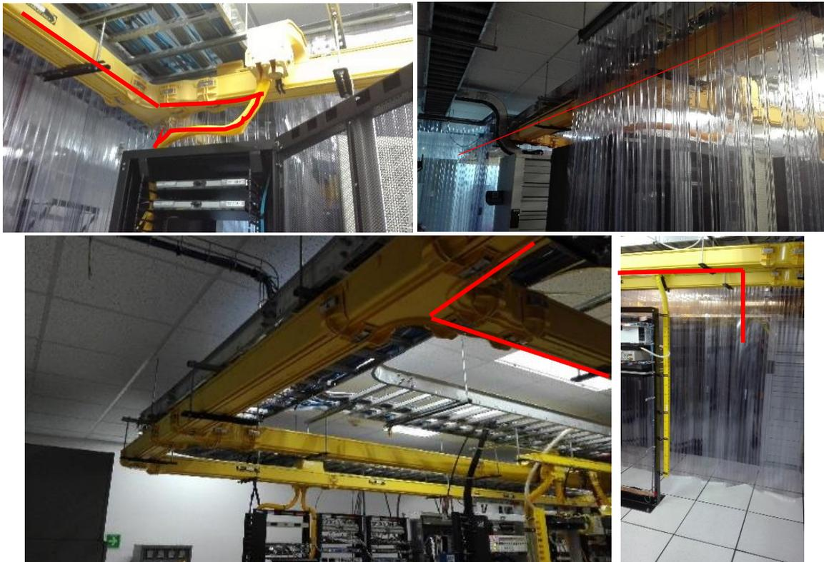
*Figura 3.12. Trayectoria F.O. Rack de Datos – Sala de Transmisión Rack Cliente.*
