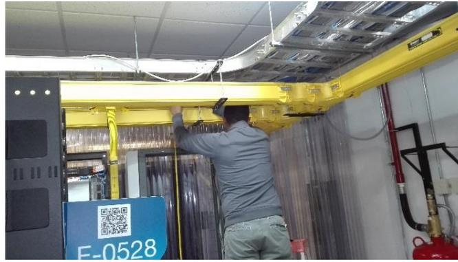
*Figura 4.3. Tendido de jumper por canaleta asignada.*
