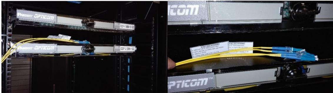
Figura 4.2. Instalación de Dos Fibras ópticas en Rack de Datos 24.
