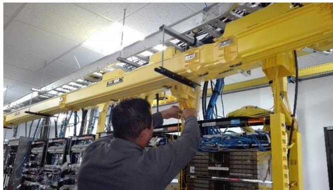
*Figura 4.4. Bajada de Fibra en ODF Anillo Primario Puerto 17 y 18 (WDM).*
