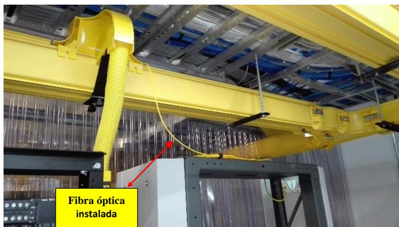
*Figura 4.5. Instalación de Fibra Óptica en Rack del Cliente.*
