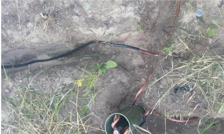
Figura 11. Punto de conexión del sistema de tierra física con el conductor aislado.
