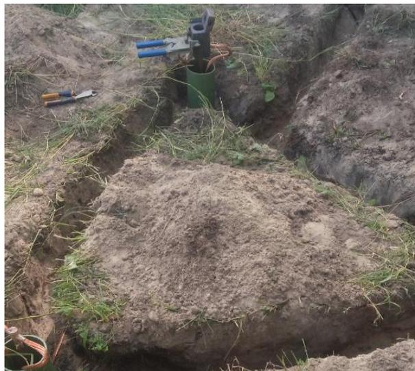
Figura 10. Construcción de sistema de tierra física para equipo de Resonancia Magnética.
