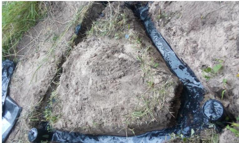
Figura 12. Uso de compuesto GEM para mejorar la conducción del sistema de tierra física.
