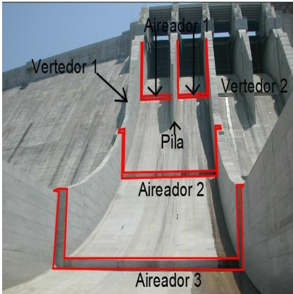
Figura 4.2. Características hidráulicas y de aireación de los vertedores en la presa Huites
