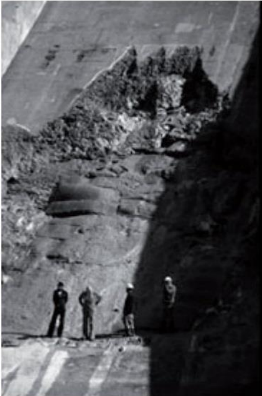
Figura 3.13. Daño por cavitación en la superficie del vertedor de la presa Karun (Gómez Arteaga, 2016)
