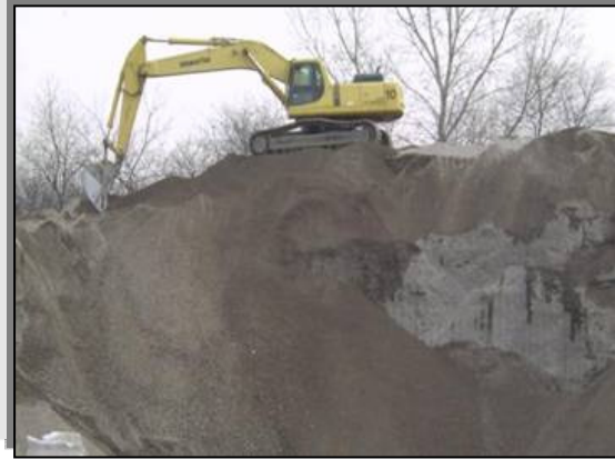
Figura 3.2 Extracción de material en banco
