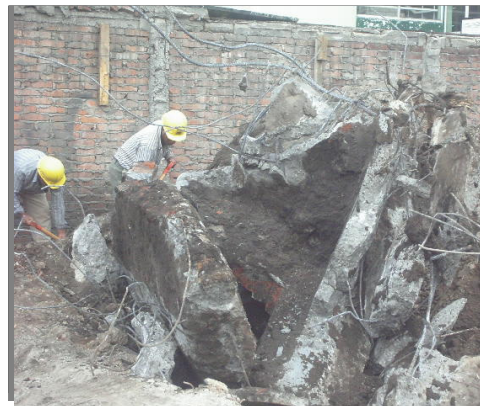
Figura 3.7 Trabajos de demolición
