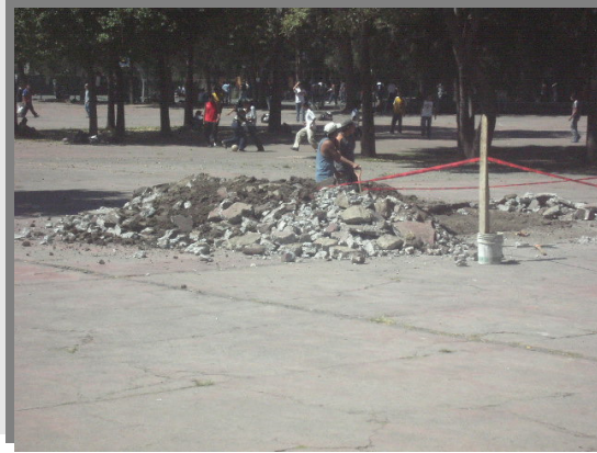
Figura 3.9 Obras de mantenimiento
