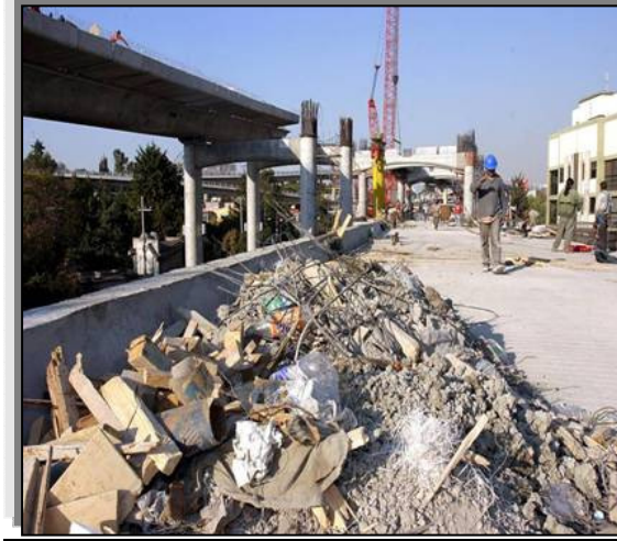
Figura 3.6 Construcción del 2º piso del periférico, D.F.
