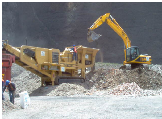
Figura 2.10 Alimentación del proceso por medios mecánicos.
