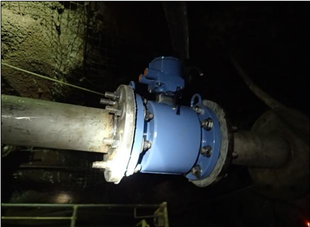
Figura 111. Instalación de flujómetro en el nivel 1160
