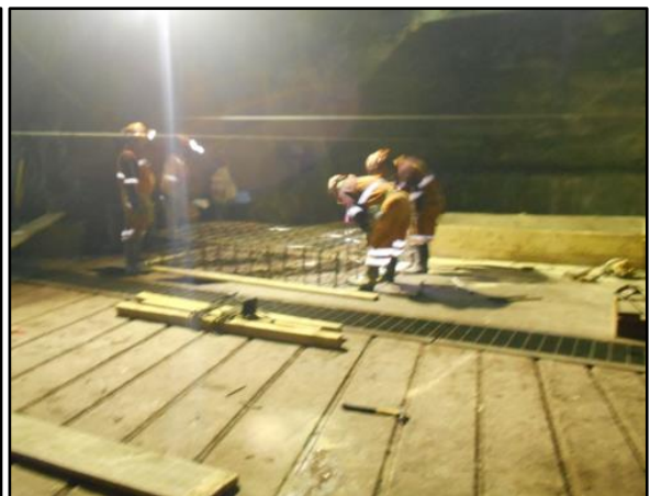
Figuras 94 y 95. Armado de las bases para las bombas Vogel
