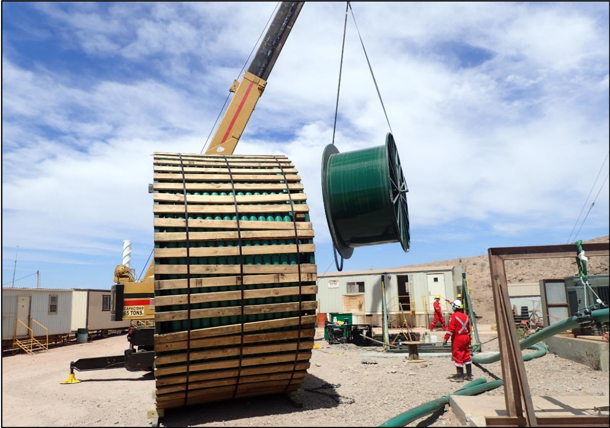
Figura 68. Maniobra para el cambio de carrete
