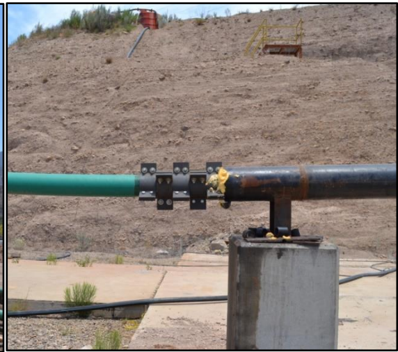
Figuras 73 y 74. Extremo final de la tubería del segundo carrete con brida y abrazaderas de soporte
