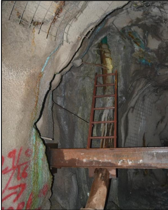
Figuras 76 y 77. Llegada de la tubería de fibra de vidrio al nivel 790 y colocación de brida
