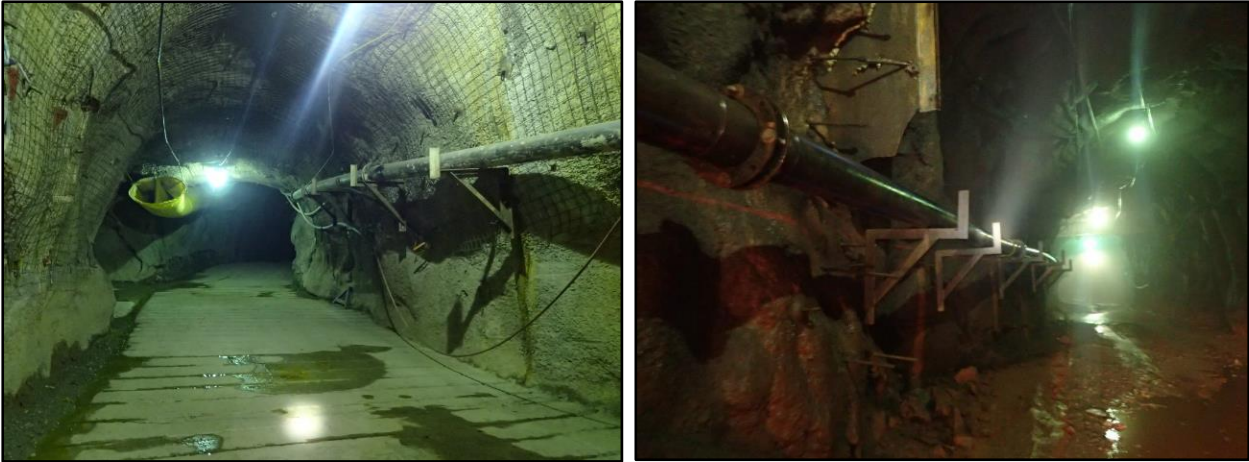
Figuras 48 y 49. Diseño y colocación de los soportes nivel 790 y 1160
