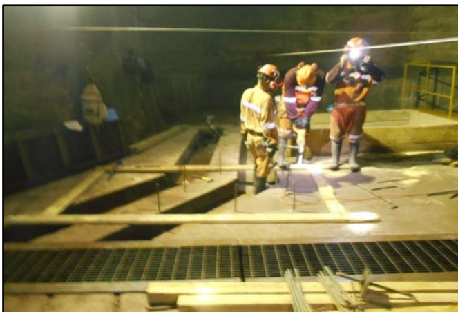
Figuras 94 y 95. Armado de las bases para las bombas Vogel
