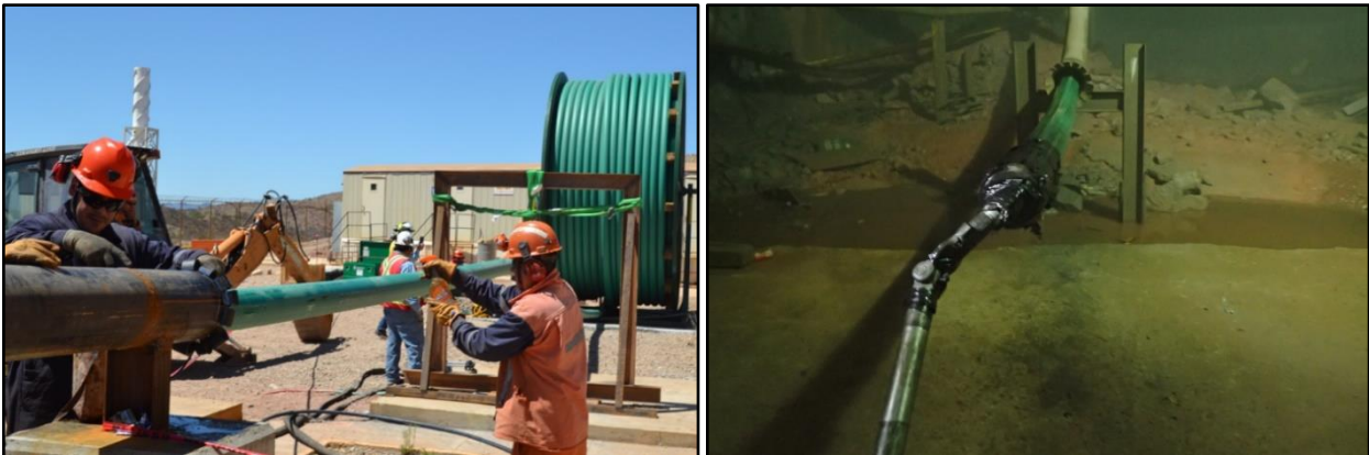
Figuras 62 y 63. Instalación del primer carrete
