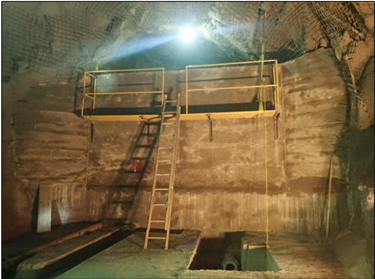
Figuras 93. Acabado del muro de la pileta en el nivel 1160
