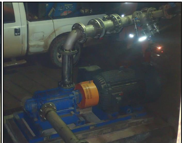
Figuras 107 y 108. Cierre de cabezales con cada bomba
