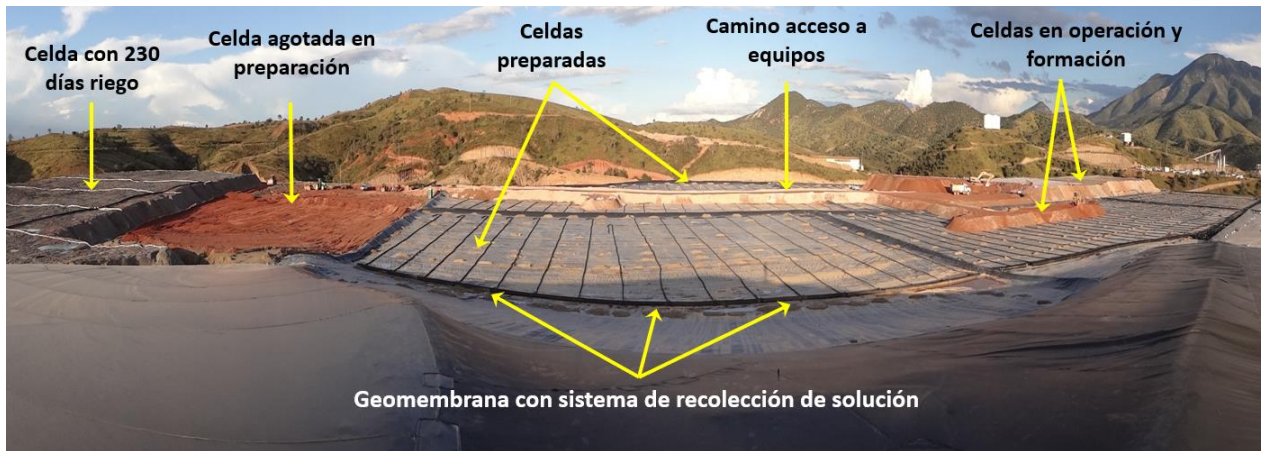
Figura 15. Construcción de celdas en patios
