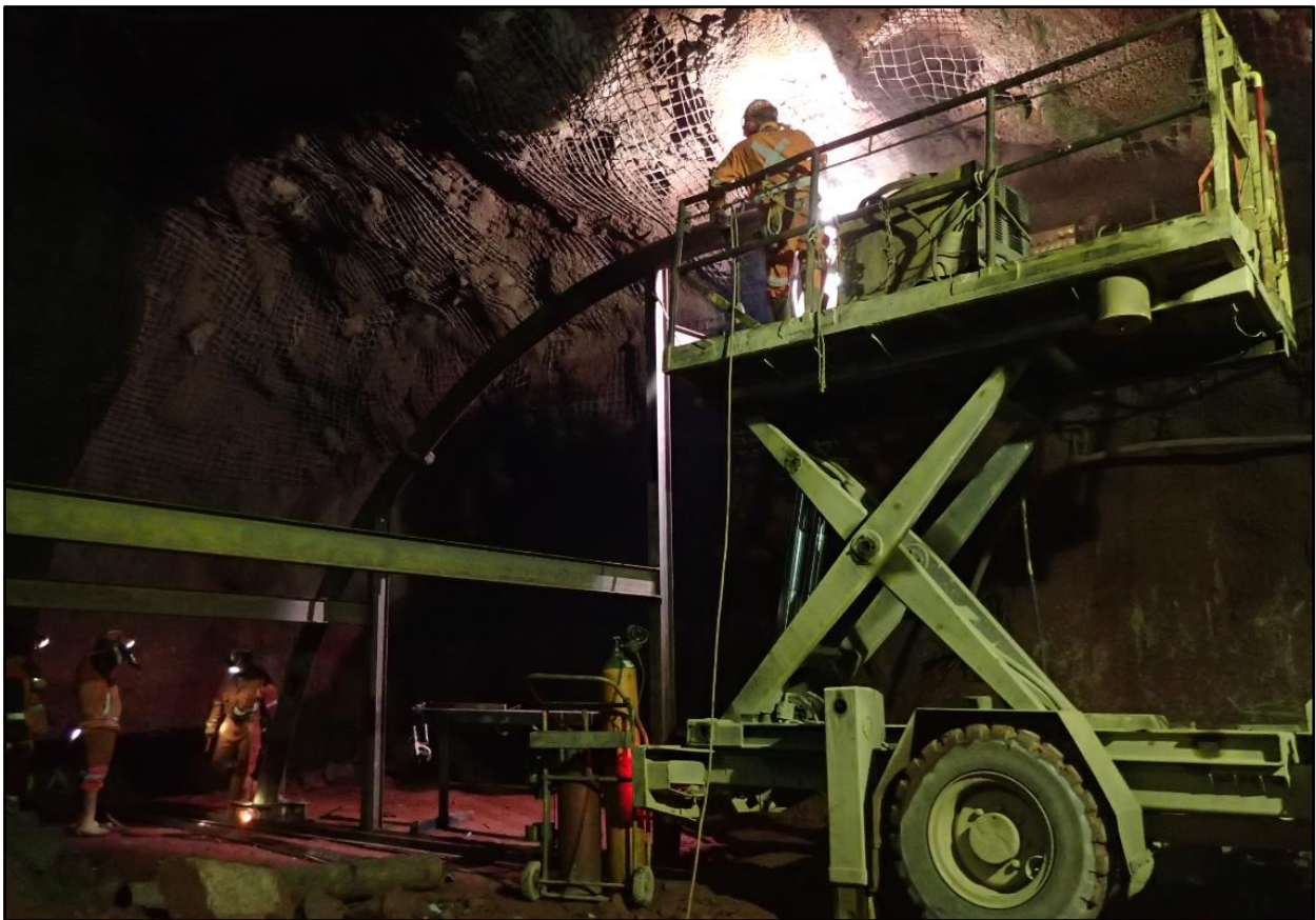
Figura 70. Fabricación de la estructura de soporte en el barreno piloto (nivel 1160)
