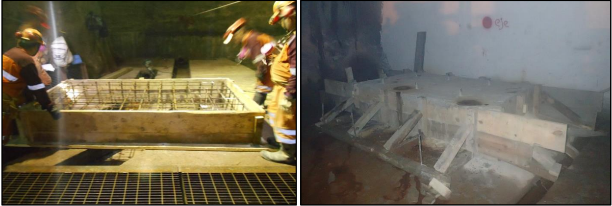
Figuras 96 y 97. Cimbrado y vaciado de las bases para las bombas
