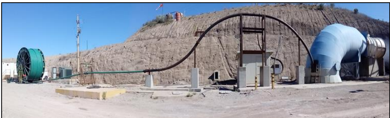
Figura 64. Bajada de la tubería desde superficie
