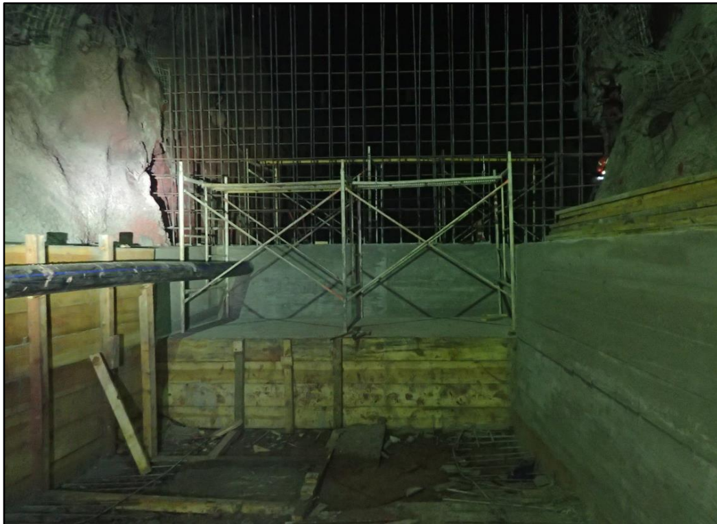
Figura 92. Armado de la pileta en el nivel 1160
