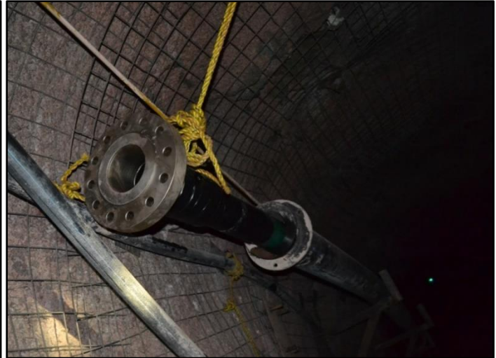
Figuras 76 y 77. Llegada de la tubería de fibra de vidrio al nivel 790 y colocación de brida
