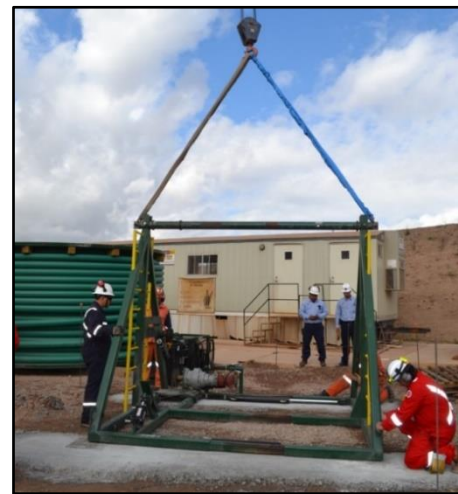
Figuras 54 y 55. Armado del freno hidráulico
