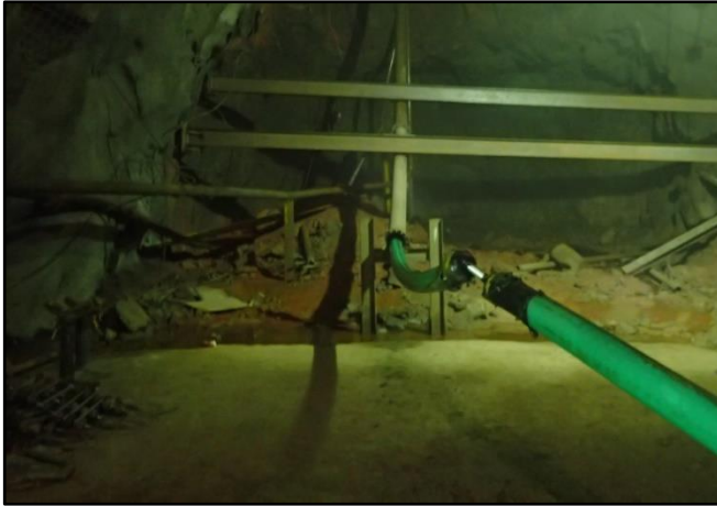
Figuras 71 y 72. Llegada de la tubería de fibra de vidrio del segundo carrete al nivel 1160, tubería soportada con eslingas de carga y retroexcavadora
