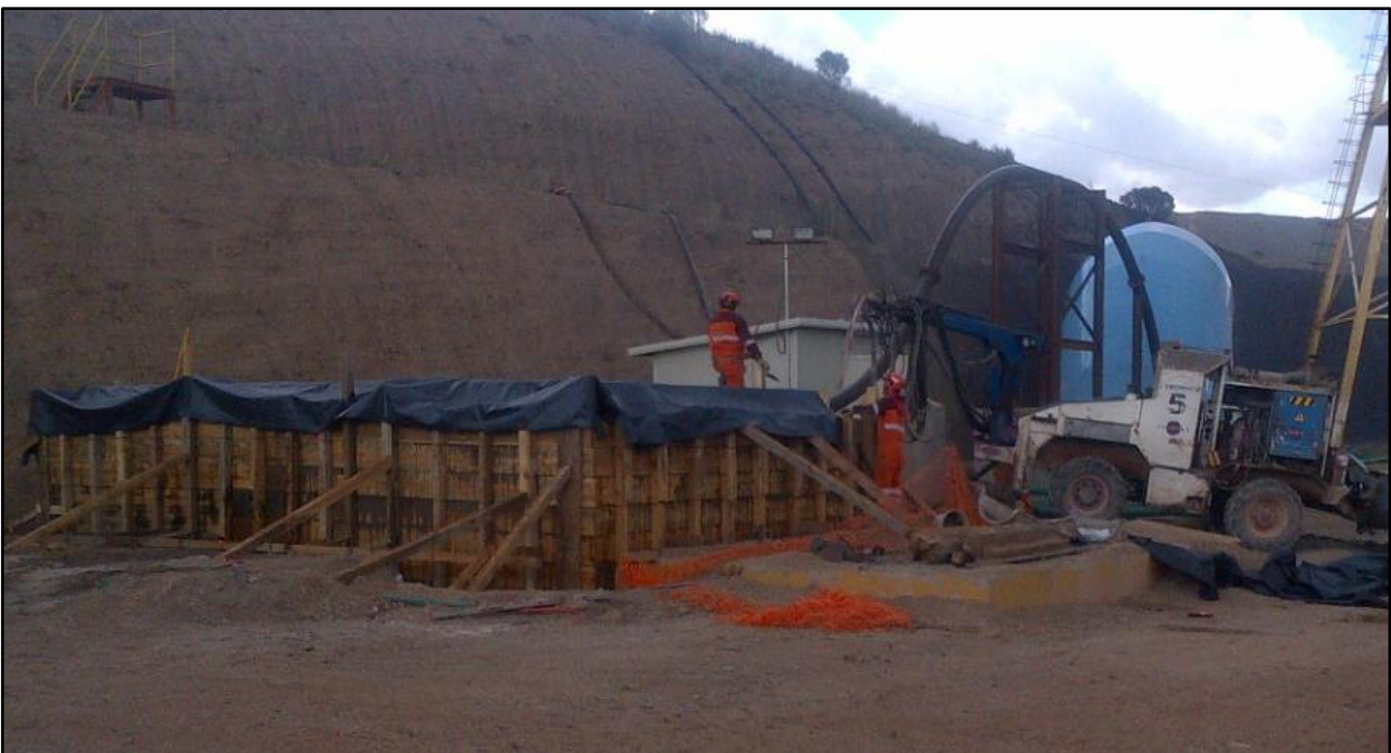
Figuras 86, 87, 88, 89 y 90. Construcción de la pileta en superficie
