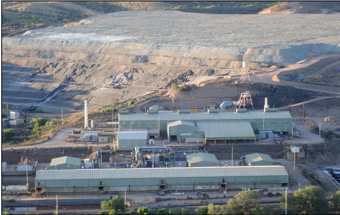
Figura 16. Infraestructura ESDE Milpillas
