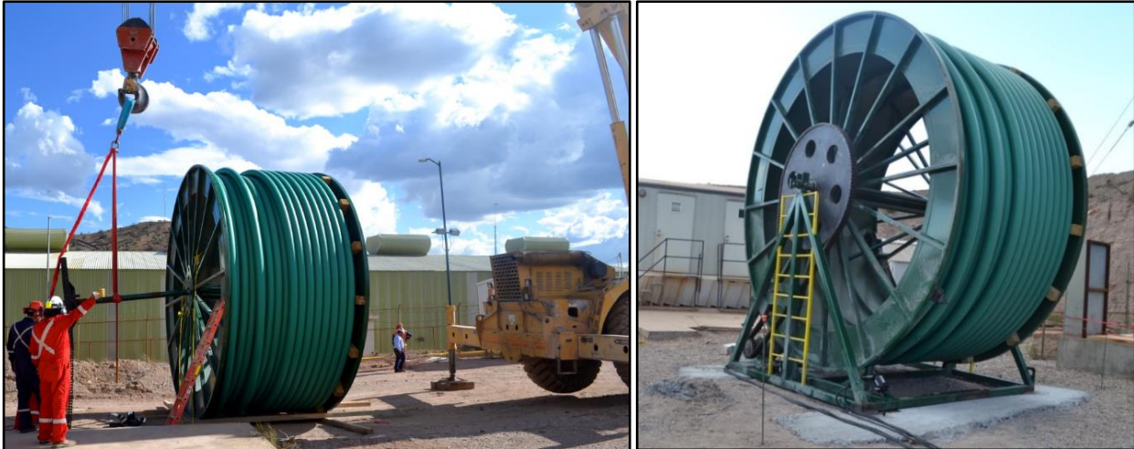
Figuras 58 y 59. Instalación del primer carrete (continuación)
