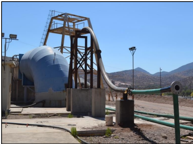
Figuras 73 y 74. Extremo final de la tubería del segundo carrete con brida y abrazaderas de soporte
