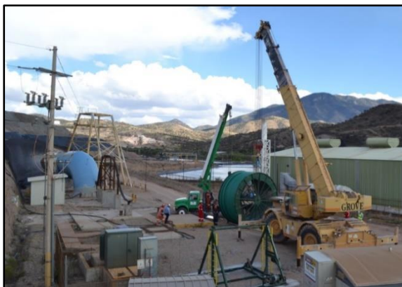
Figuras 56 y 57. Instalación del primer carrete
