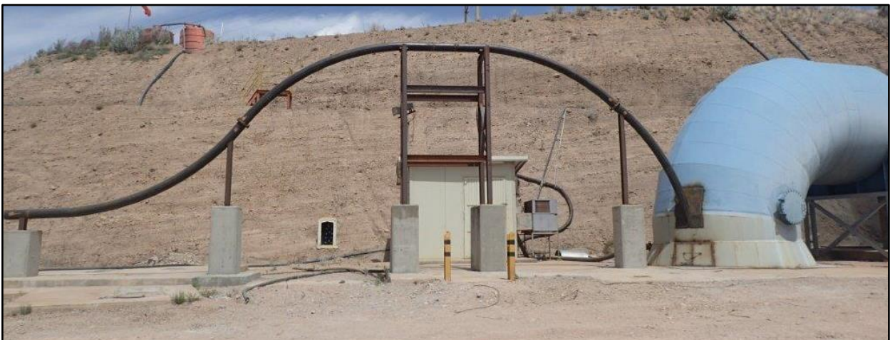
Figura 51. Estructura en superficie terminada
