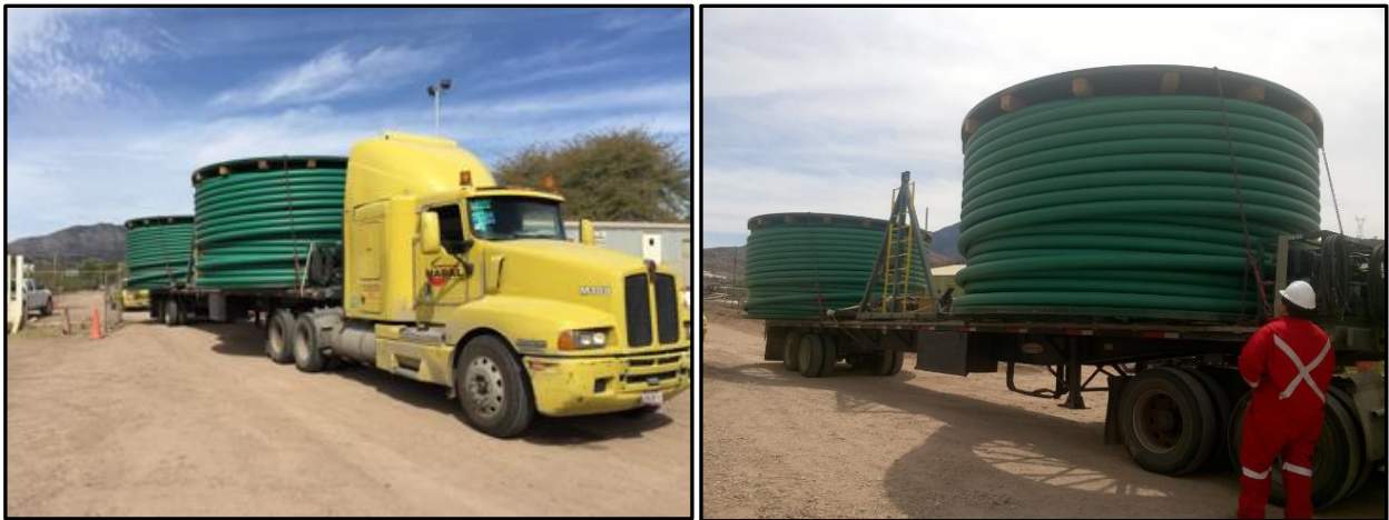
Figuras 44 y 45. Presentación y llegada de la tubería a unidad Milpillás
