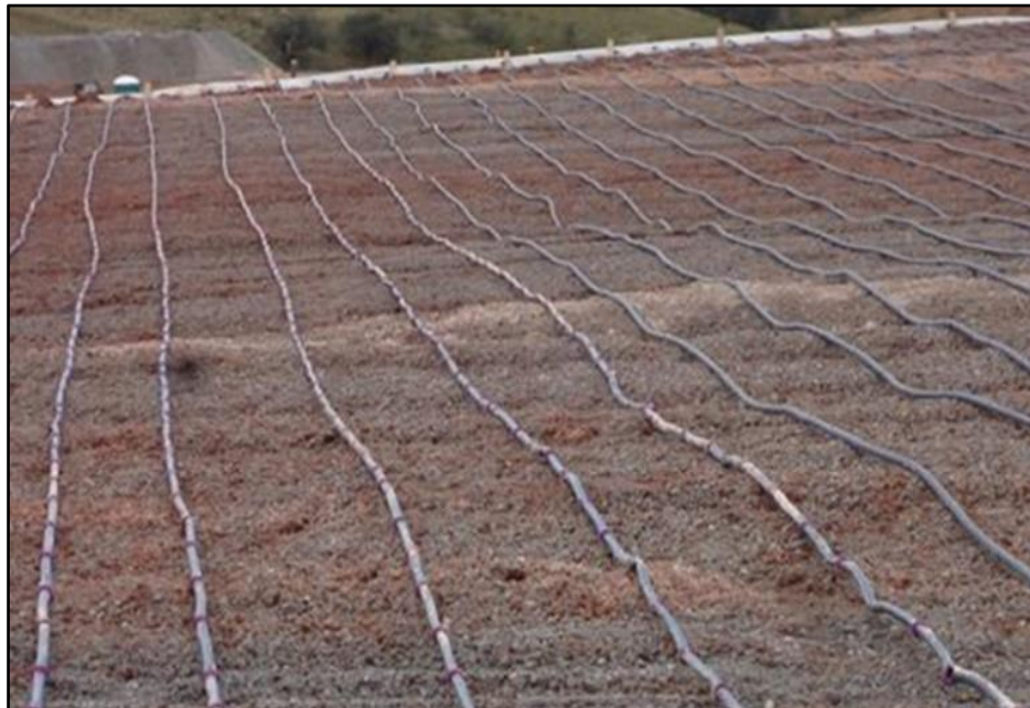
Figura 14. Tubería de riego en celdas de patios
