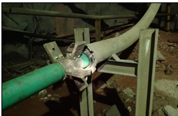
Figura 75. Abrazadera de soporte y colocación de brida en nivel 1160
