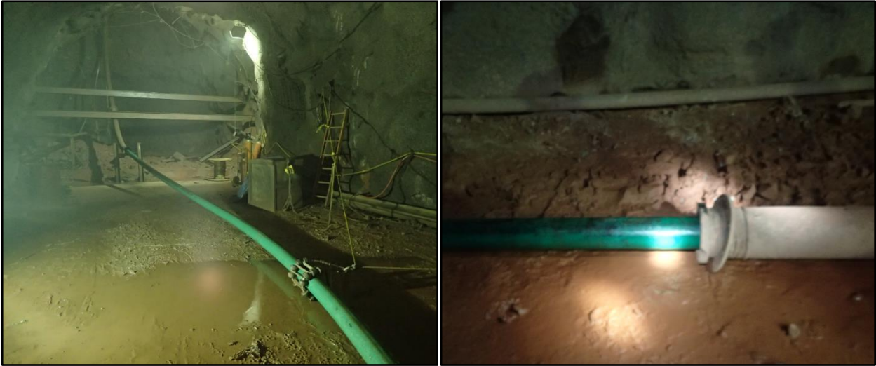
Figuras 65 y 66. Se tiende la tubería de fibra de vidrio del primer carrete por el nivel 1160 y se protege con la tubería PEAD
