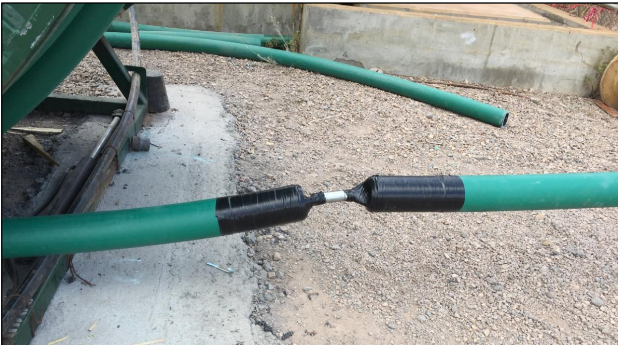
Figura 69. Se ensambla el final de la tubería del primer carrete con el inicio del segundo
