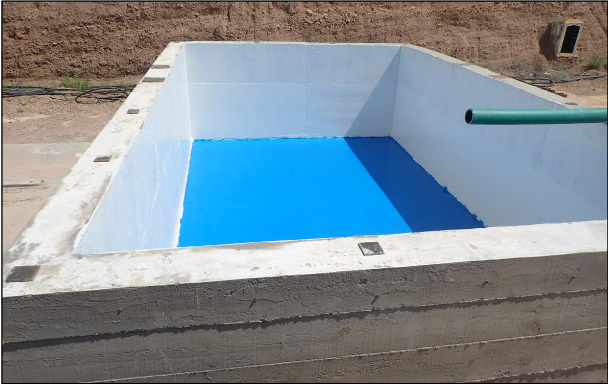
Figura 91. Acabado interior de la pileta en superficie con recubrimiento epóxico
