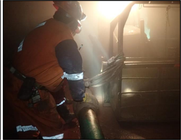
Figuras 71 y 72. Llegada de la tubería de fibra de vidrio del segundo carrete al nivel 1160, tubería soportada con eslingas de carga y retroexcavadora
