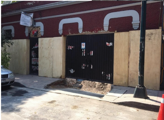
Colocación de tapial de madera para colocación de publicidad.
