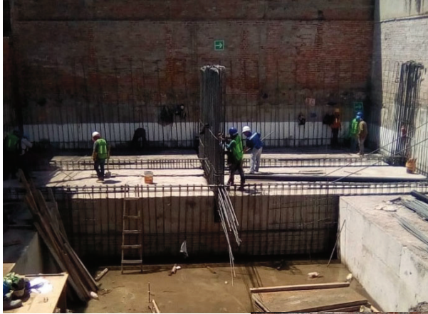
Armado de losa de cimentación y contratrabes
