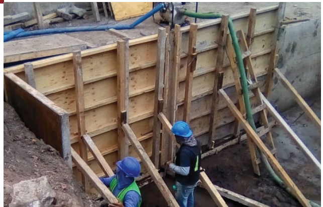
Cimbrado con madera común de muros de cisterna
