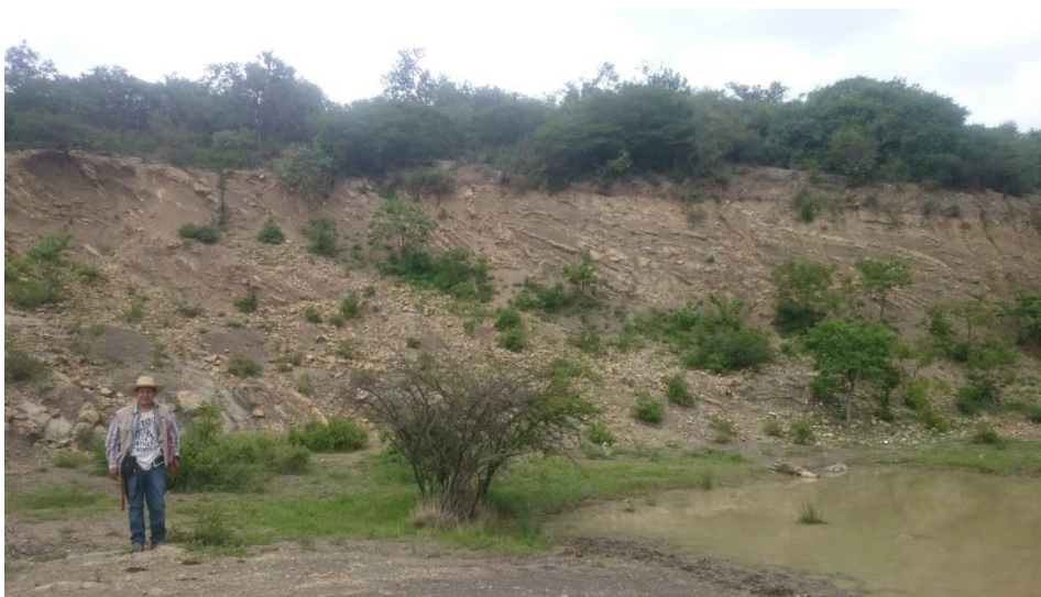
Figura 12. Pliques estructurales menores que presenta la Formación Solano en la Localidad 1 (Banco de material en la carretera Huajuapán de León-Mariscala). Vista hacia el sector Oriental del afloramiento.
