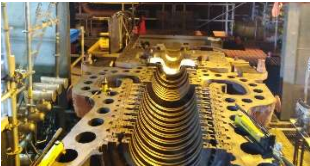
Figura 10. Limpieza de canales para toma de lecturas con ERAG [Fuente: Propia (Abril 2019, Perú)]
