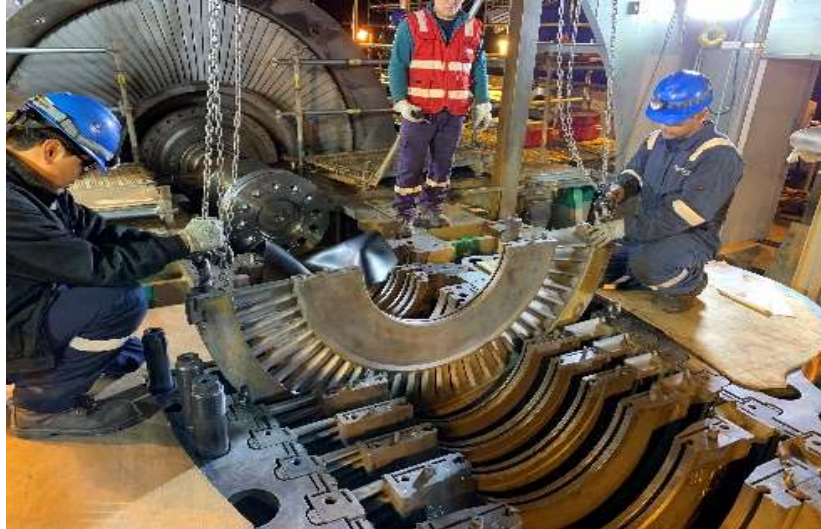
Figura 13. Maquinado de tacones y alineación de los diafragmas IP [Fuente: Propia (Abril 2019, Perú)]
