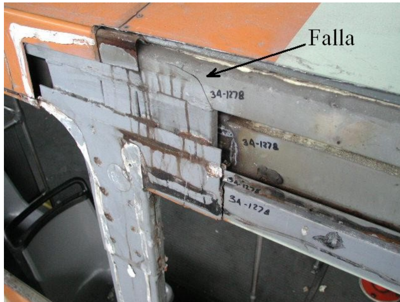
Figura 2-1. Falla en la estructura del autobús
